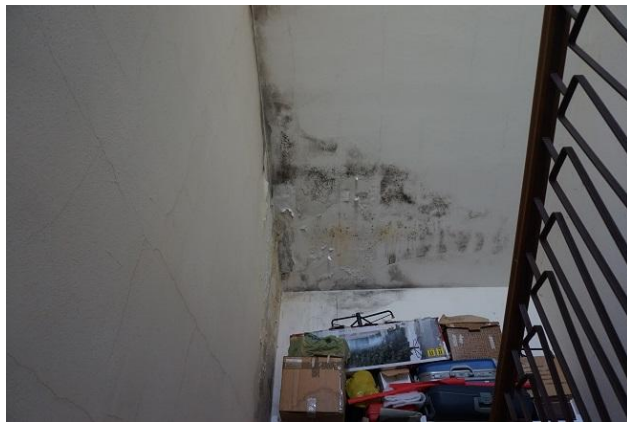
Vano scala condominiale
