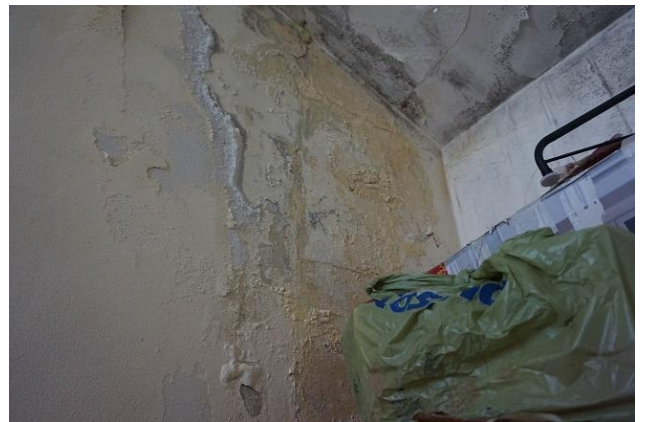
Vano scala condominiale
