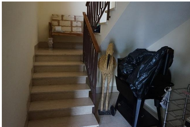
Vano scala condominiale
