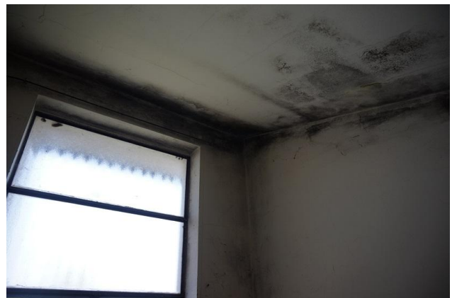
Vano scala condominiale
