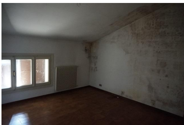
Piano secondo – Angolo nord/ovest camera ad ovest
