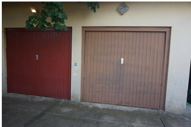
Piano Terra – Portone ingresso garage (a destra)
