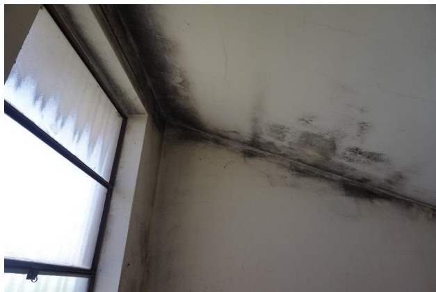
Vano scala condominiale
