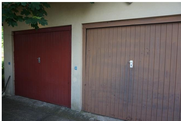
Piano Terra – Portone ingresso garage (a sinistra)
