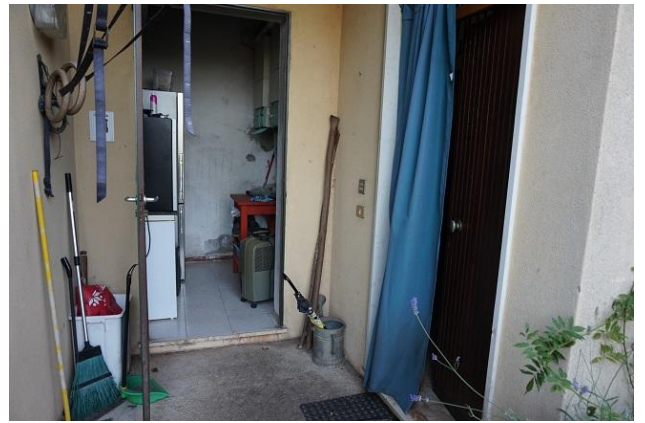
Porta caldaia e portoncino accesso vano scala (a destra)
