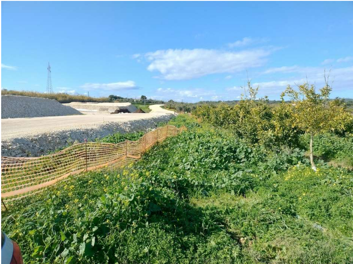
Foto 44 – Cantiere autostradale di c/da Sabuci.
