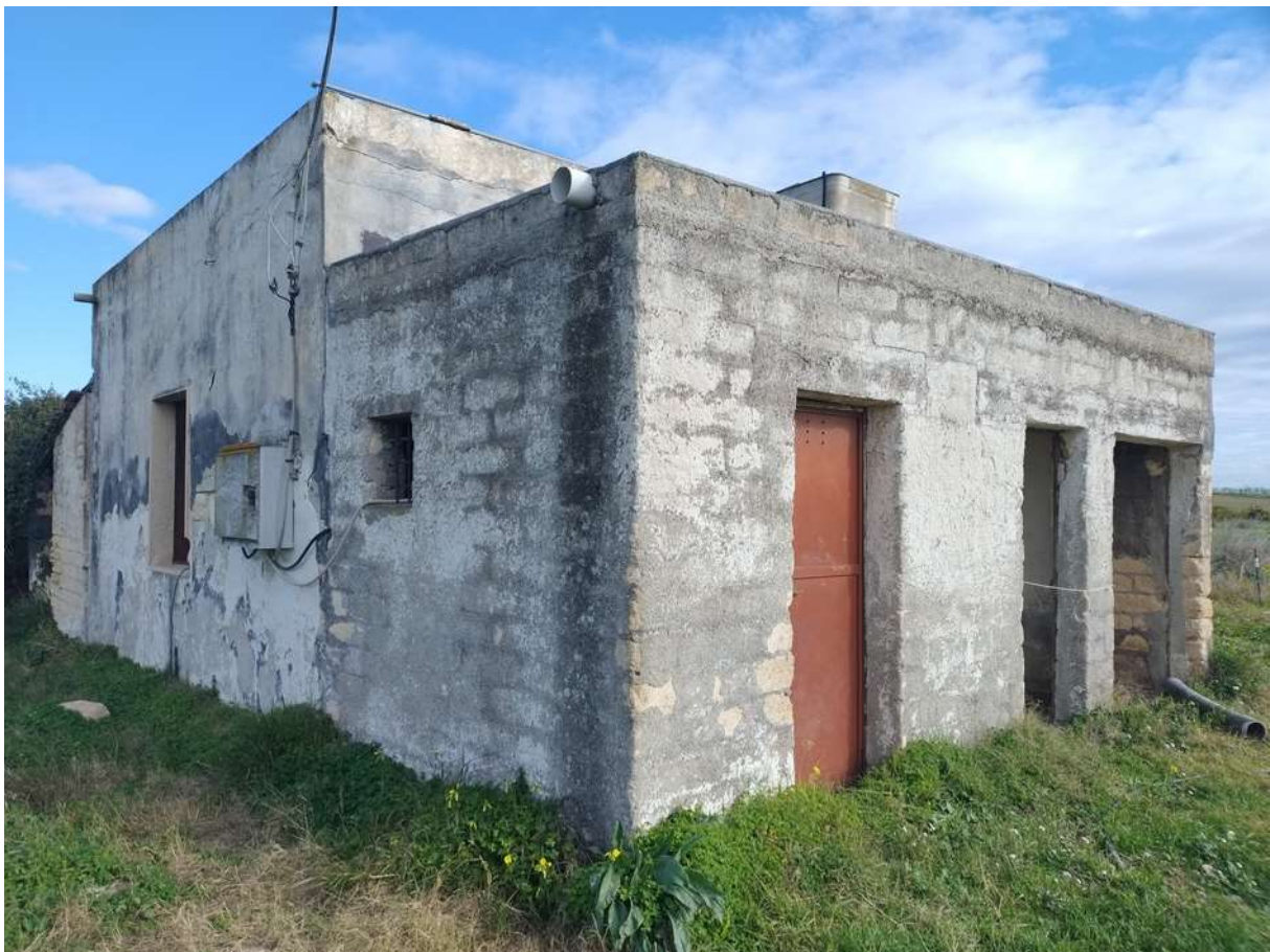
Foto 9 e 10 – Fabbricato di C/da Sabuci e pozzo trivellato.
