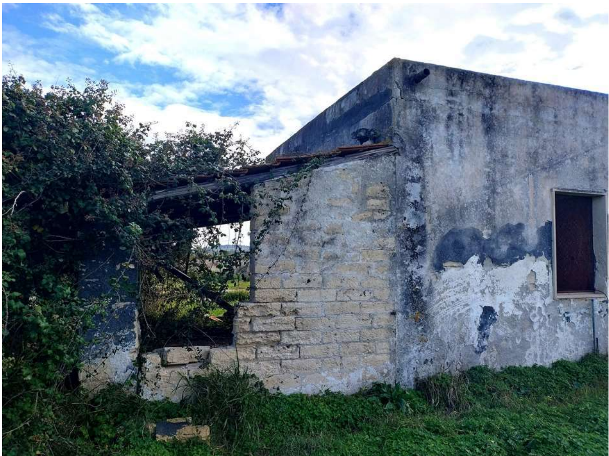
Foto 11 e 12 – Fabbricato di C/da Sabuci.
