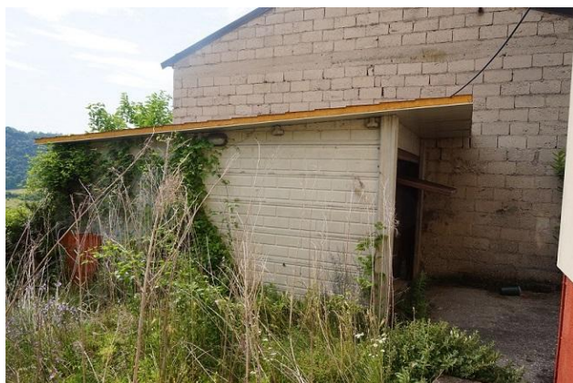
Vista garage da sud/est
