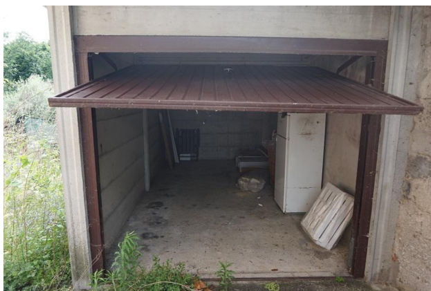
Portone basculante di accesso garage
