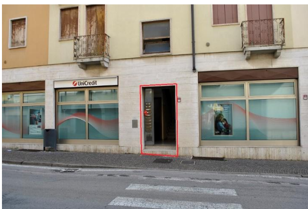
Foto 6 – via Liston San Gaetano – ingresso comune
