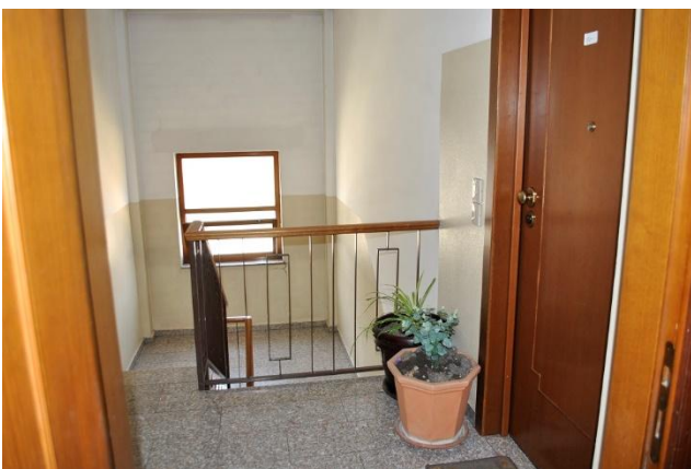
Foto 11 – vano scale comune – pianerottolo P.3
