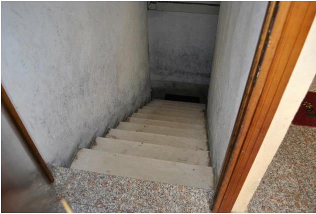
Foto 31 – vano scale comune – accesso al P.ST
