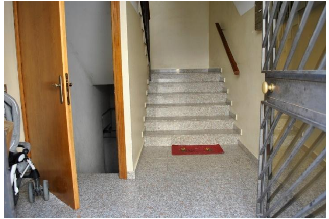
Foto 8 – ingresso/vano scale comune – P.T.
