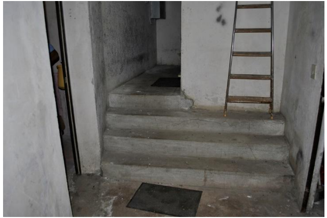
Foto 32 – corridoio comune – P.ST
