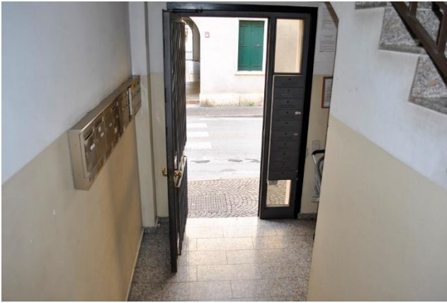
Foto 7 – ingresso/vano scale comune – P.T.
