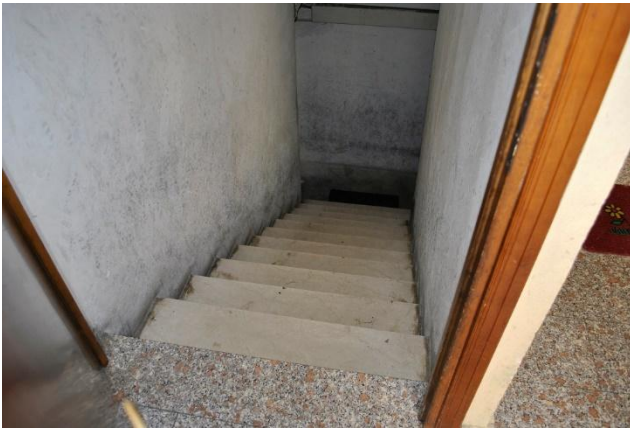
Foto 31 – vano scale comune – accesso al P.ST
