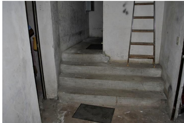
Foto 32 – corridoio comune – P.ST
