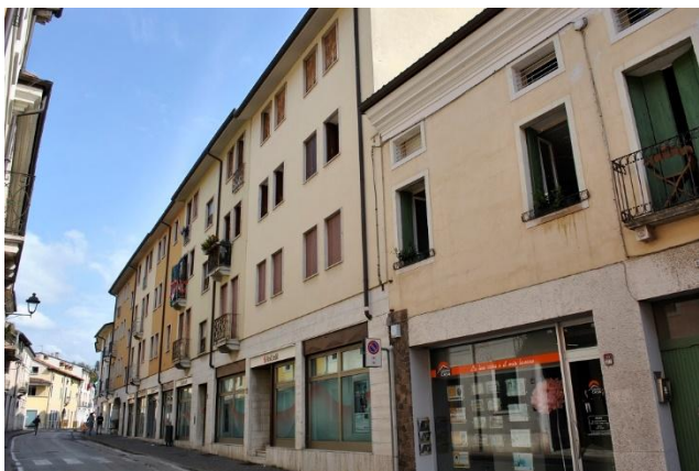
Foto 1 – vista da sud – da via Liston San Gaetano
