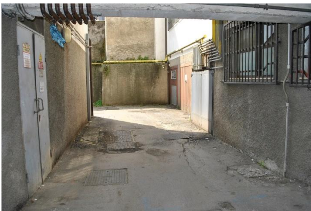
Foto 40 – spazio di manovra comune – P.ST
