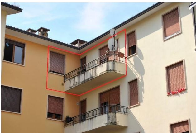
Foto 4 – vista da piazza A. De Gasperi - particolare
