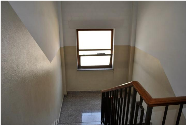
Foto 9 – vano scale comune
