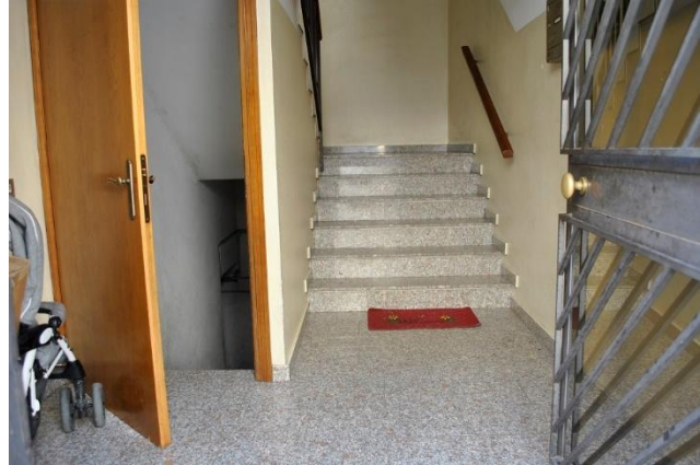
Foto 8 – ingresso/vano scale comune – P.T.
