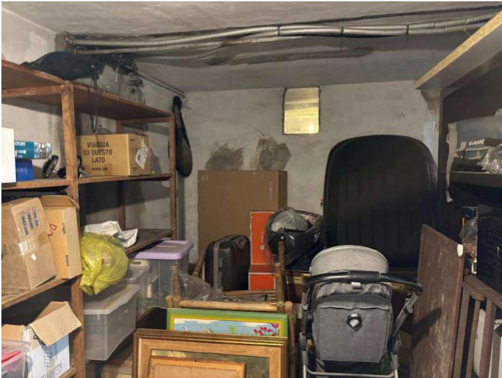
FOTO 4 – LOCALE ACCESSORIO PT
