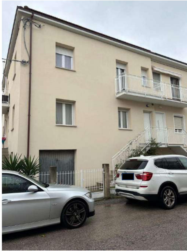
FOTO 1- PROSPETTO INGRESSO SUB.3 VIA STOPPANI
