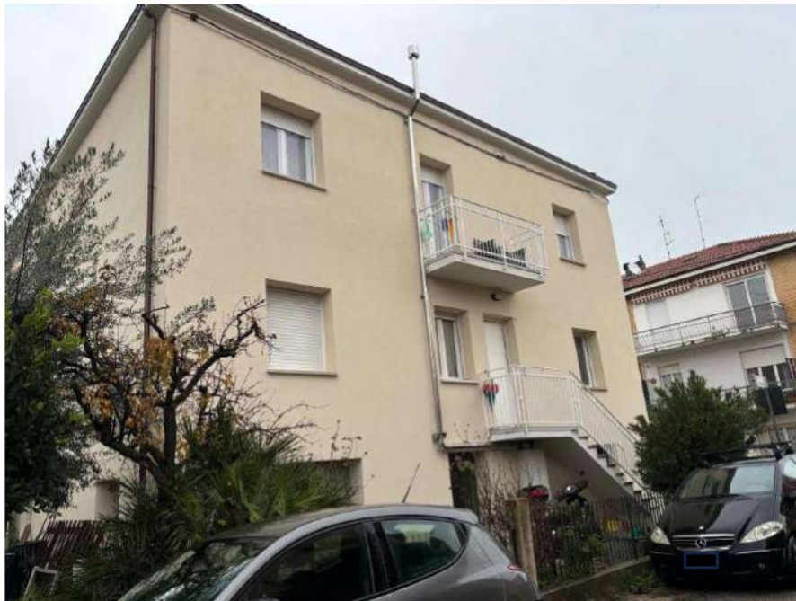
FOTO 2- PROSPETTO INGRESSO SUB.2 VIA BONFANTE
