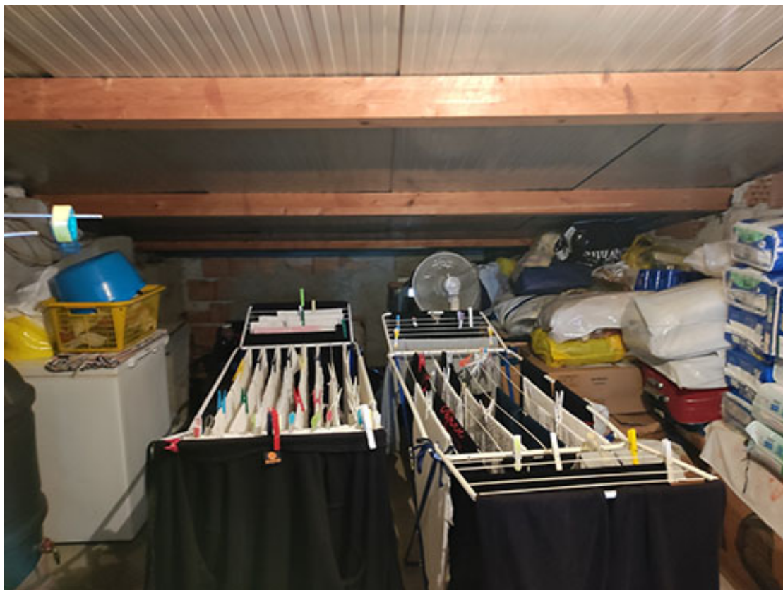
Foto 14: Giffone foglio 3 particella 402 sub. 4 – Sottotetto
