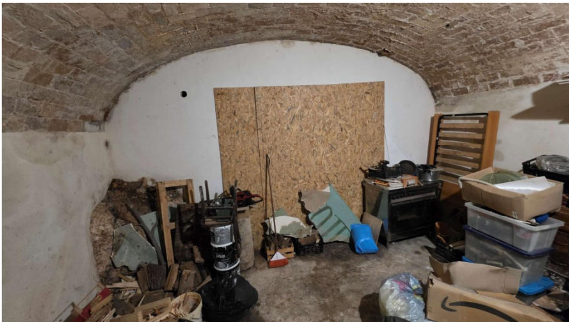
FOTO 4: piano terra, cantina, secondo vano (sub 2)
