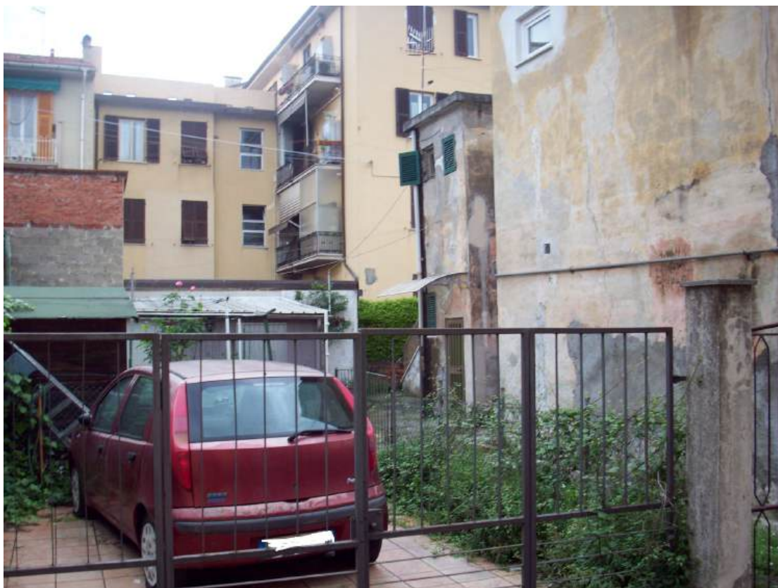
Foto n. 11 – Vista da Via Taravacci – area esterna particella 480
