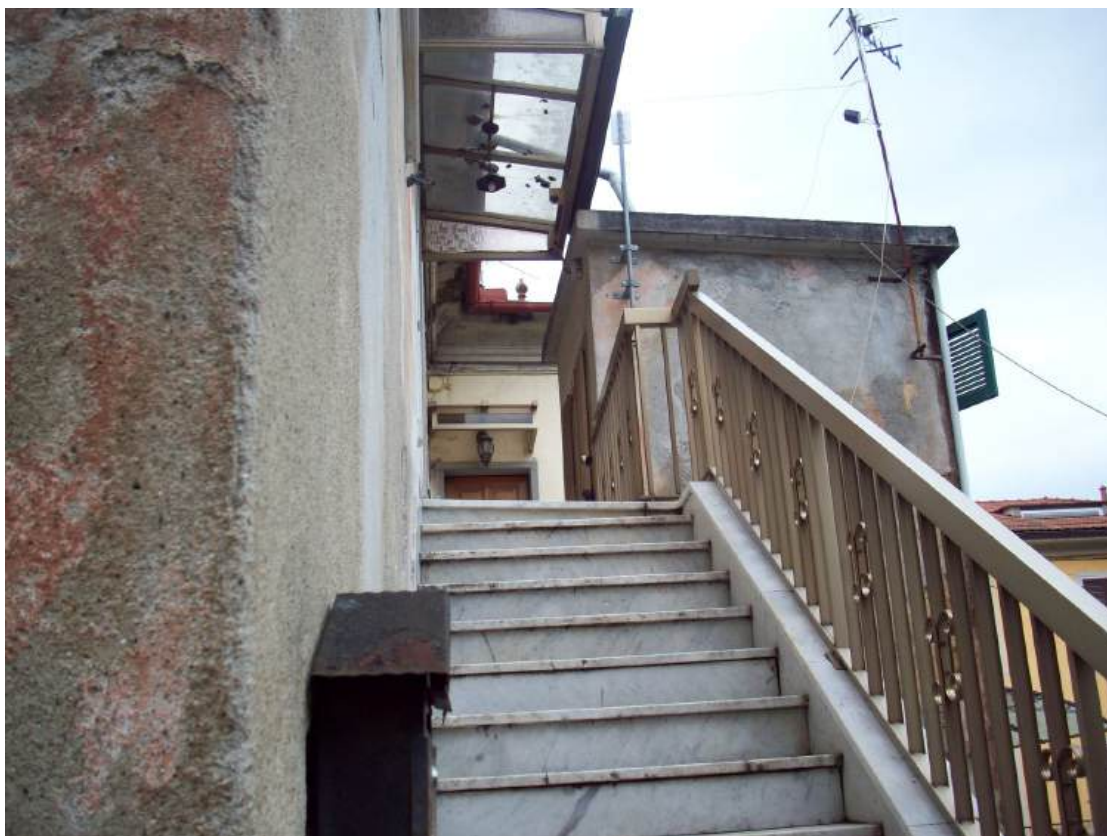
Foto n. 9 – scala di accesso al primo piano
