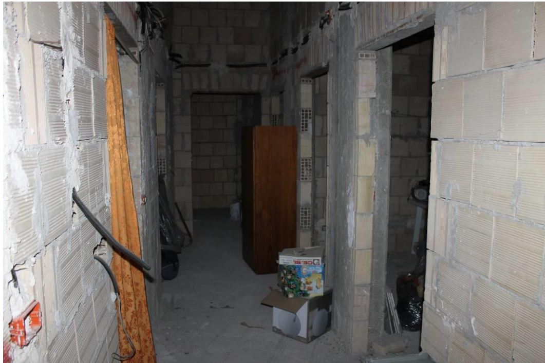
vista interna dell'unità immobiliare in corso di costruzione (NCEU Castel di Ieri, fg.3, part.855, sub 4)
