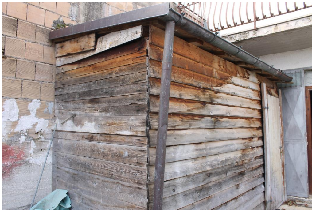
vista del manufatto precario in legno sul fronte posteriore del fabbricato
