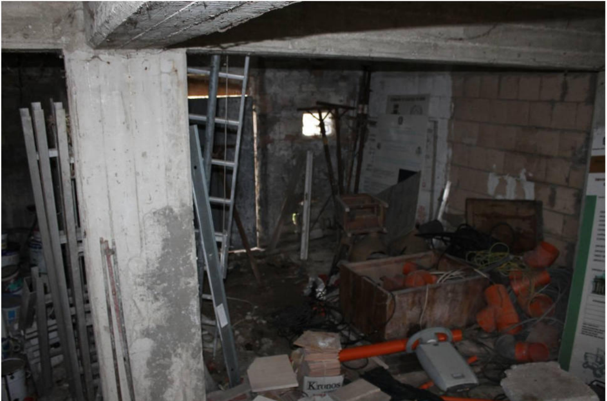
FOTO N. 22 - Vista interna del fabbricato in corso di costruzione (sub 5 - piano seminterrato)
