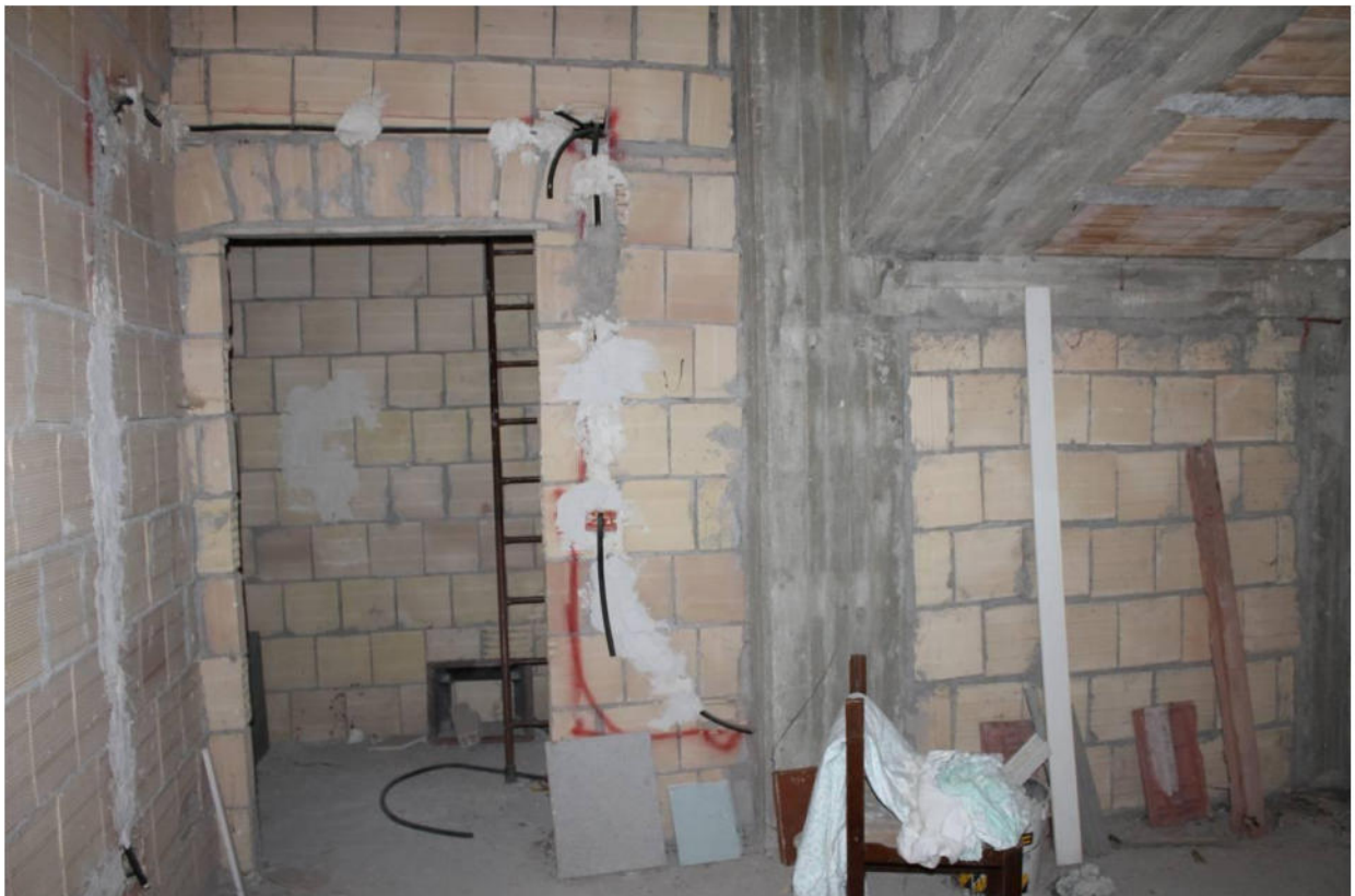
FOTO N. 14 - Vista interna della porzione di fabbricato in corso di costruzione (sub 4 - sottotetto)
