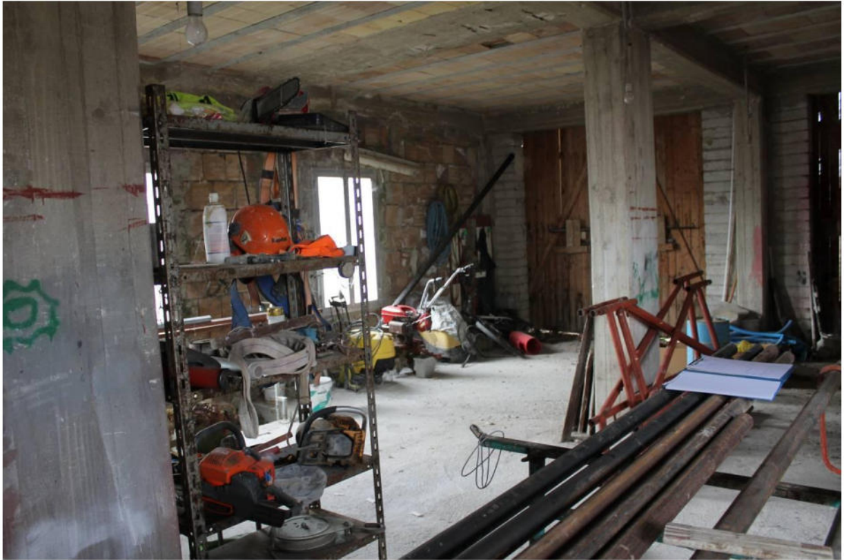
FOTO N. 19 - Vista interna del fabbricato in corso di costruzione (sub 5 - piano terra)
