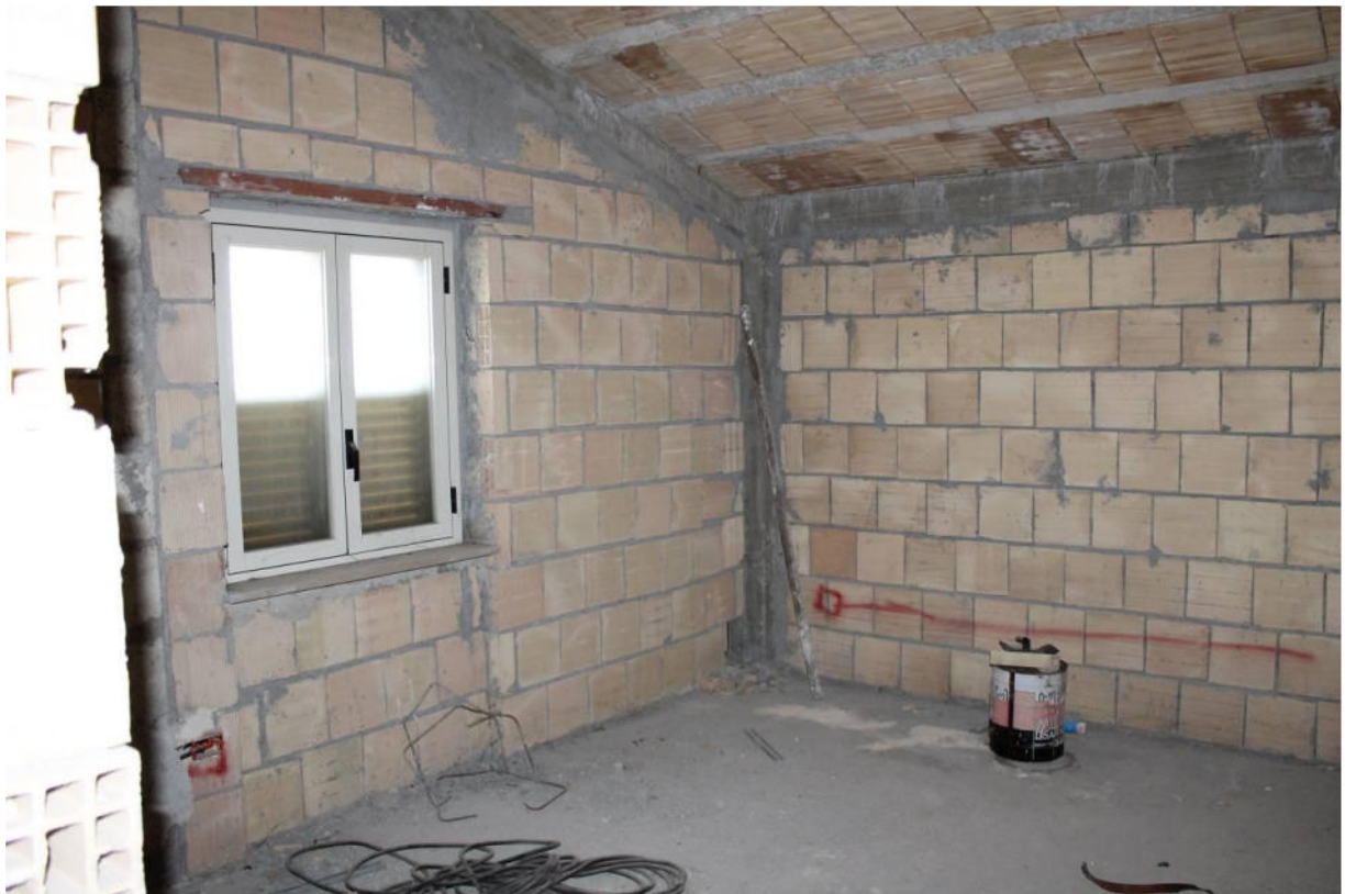
FOTO N. 15 - Vista interna della porzione di fabbricato in corso di costruzione (sub 4 - sottotetto)
