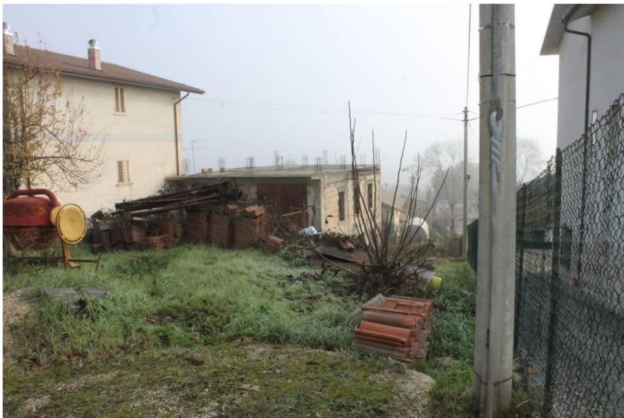
FOTO N. 17 - Vista del fabbricato in corso di costruzione (sub 5 - magazzino) dalla strada (Via S. Pio)
