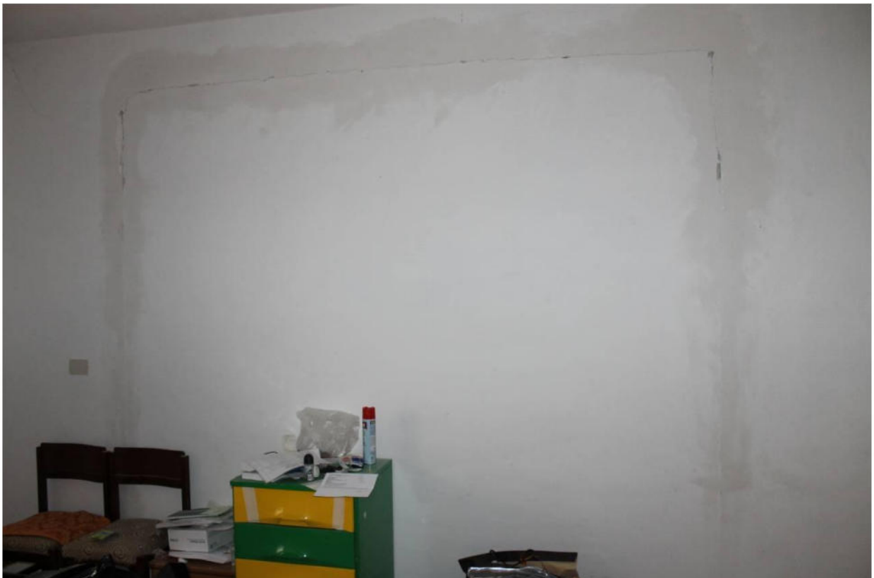
FOTO N. 12 - Vista interna della civile abitazione (sub 3): locale già destinato ad autorimessa
