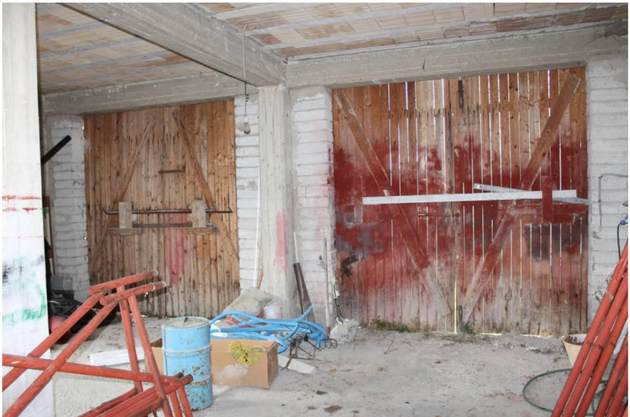
FOTO N. 20 - Vista interna del fabbricato in corso di costruzione (sub 5 - piano terra)
