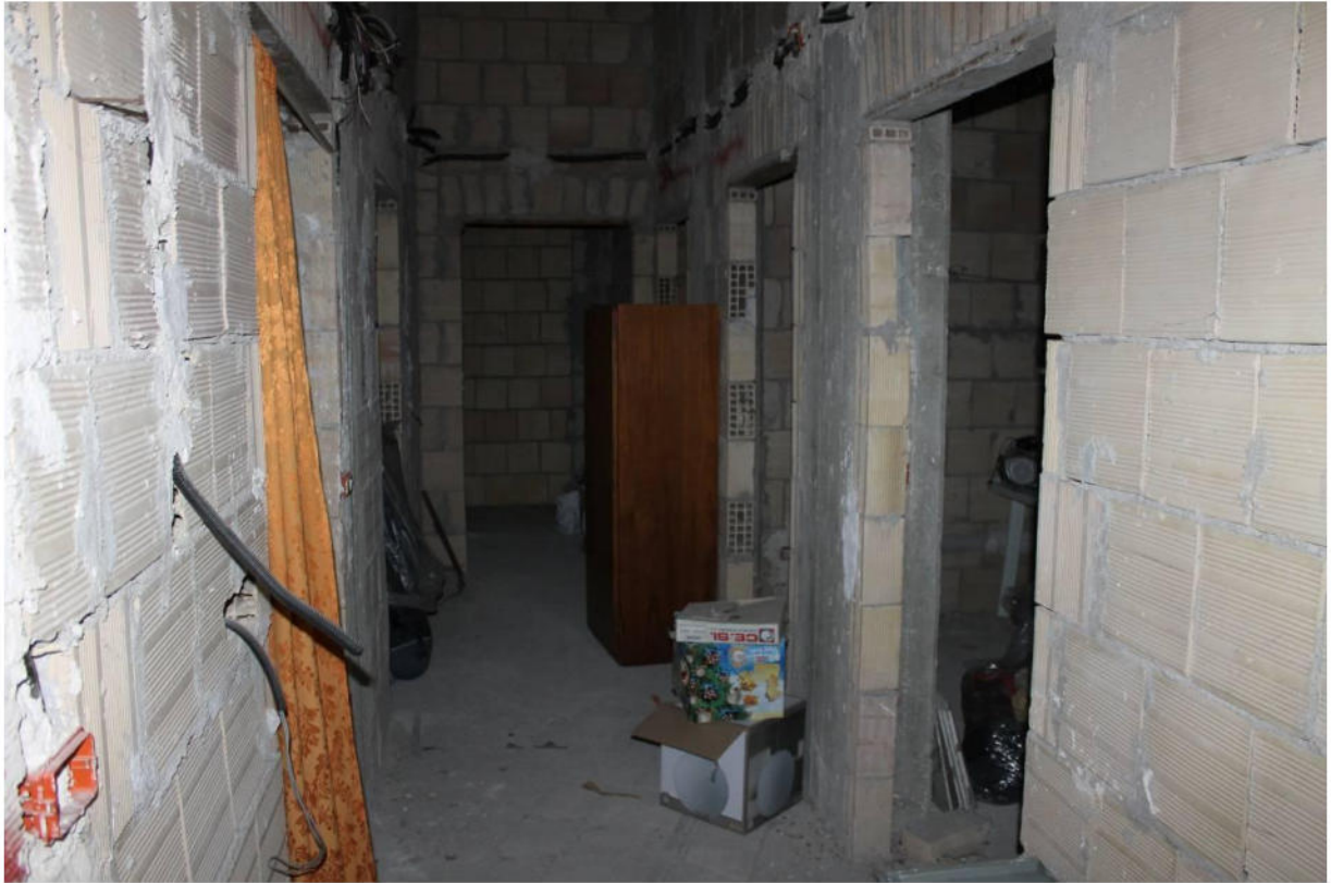
FOTO N. 13 - Vista interna della porzione di fabbricato in corso di costruzione (sub 4 - sottotetto)
