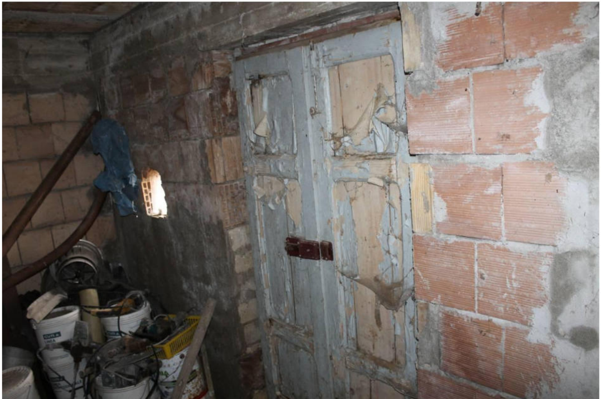
FOTO N. 23 - Vista interna del fabbricato in corso di costruzione (sub 5 - piano seminterrato): porta d'accesso
