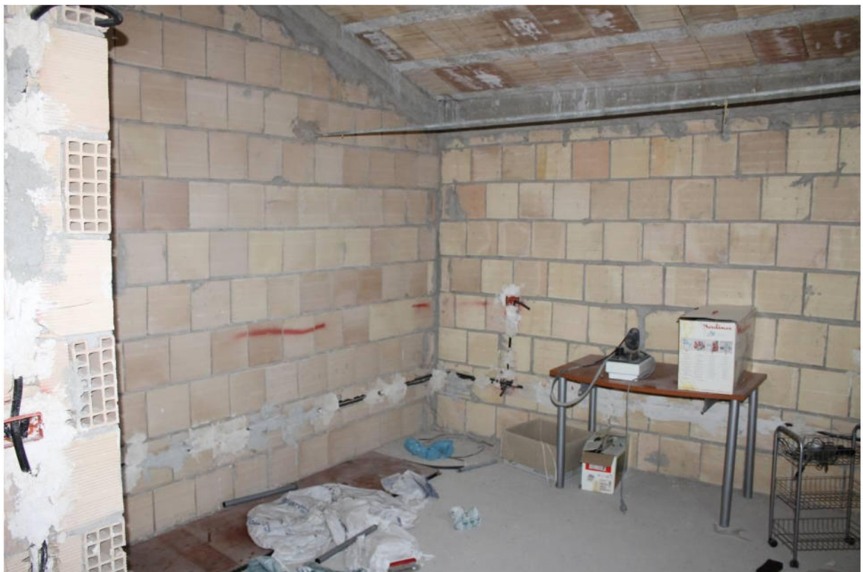
FOTO N. 16 - Vista interna della porzione di fabbricato in corso di costruzione (sub 4 - sottotetto)
