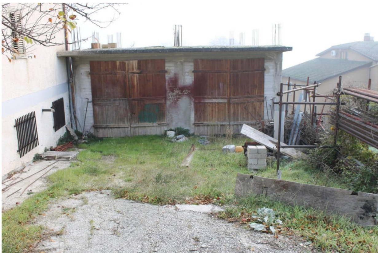
FOTO N. 18 - Vista del fabbricato in corso di costruzione (sub 5 - magazzino) dalla corte esclusiva
