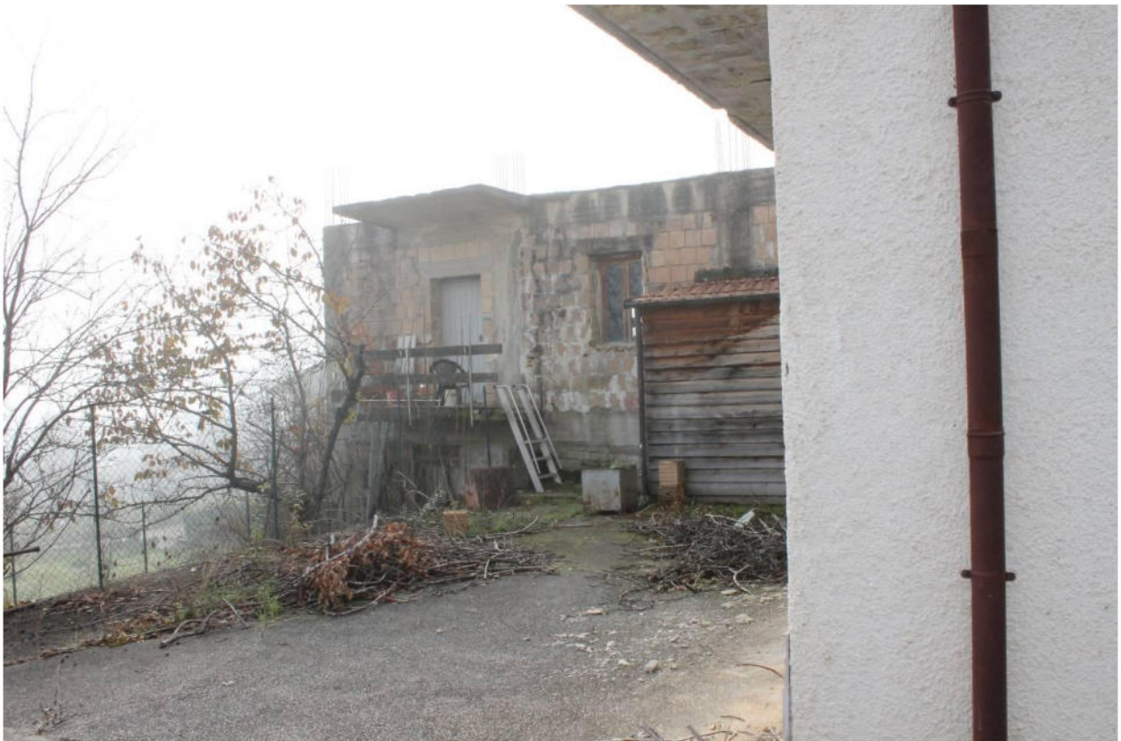
FOTO N. 24 - Vista del fabbricato in corso di costruzione (sub 5) dalla corte esclusiva dei subb 2, 3 e 4
