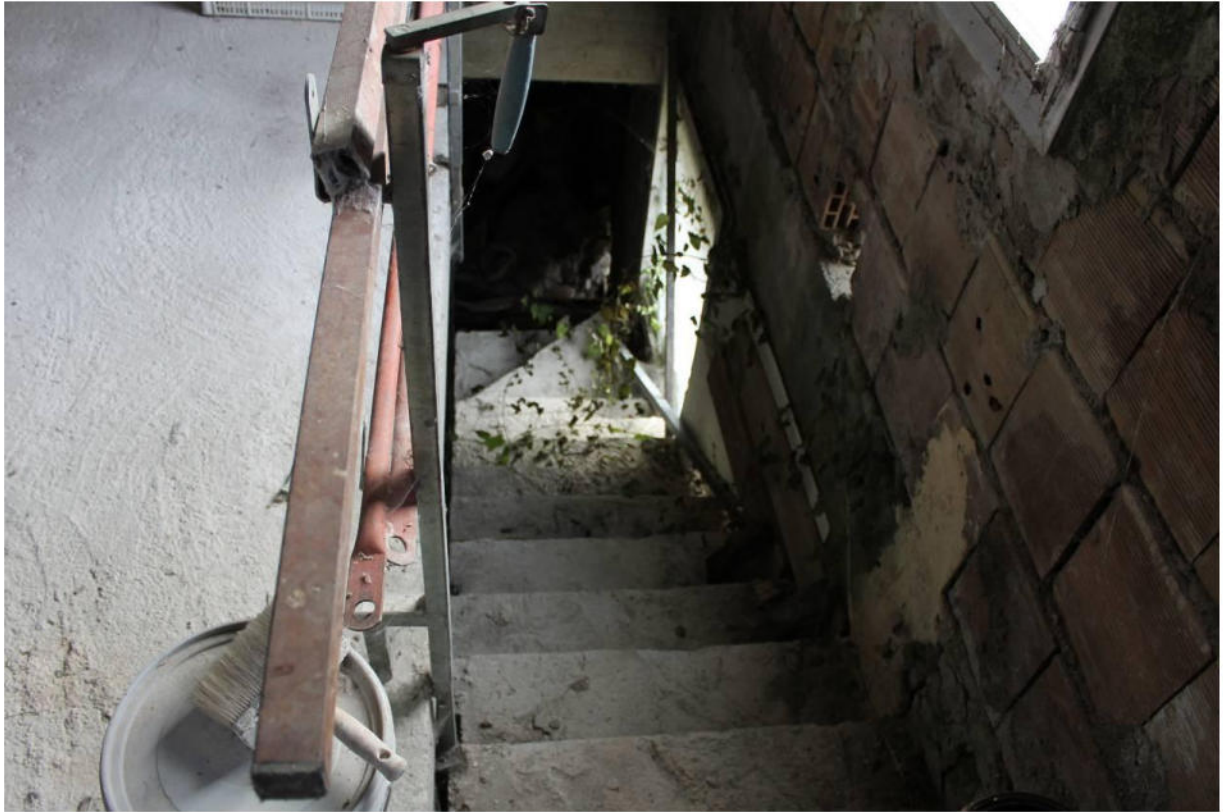
FOTO N. 21 - Vista interna del fabbricato in corso di costruzione (sub 5 - piano terra): scala interna
