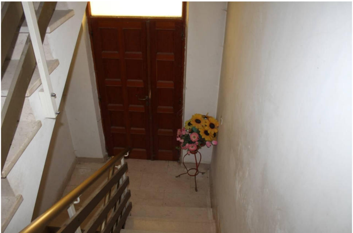
FOTO N. 5 - Vista interna della civile abitazione (sub 2 - piano terra): vano scala (ingresso comune ai subb 3 e 4)
