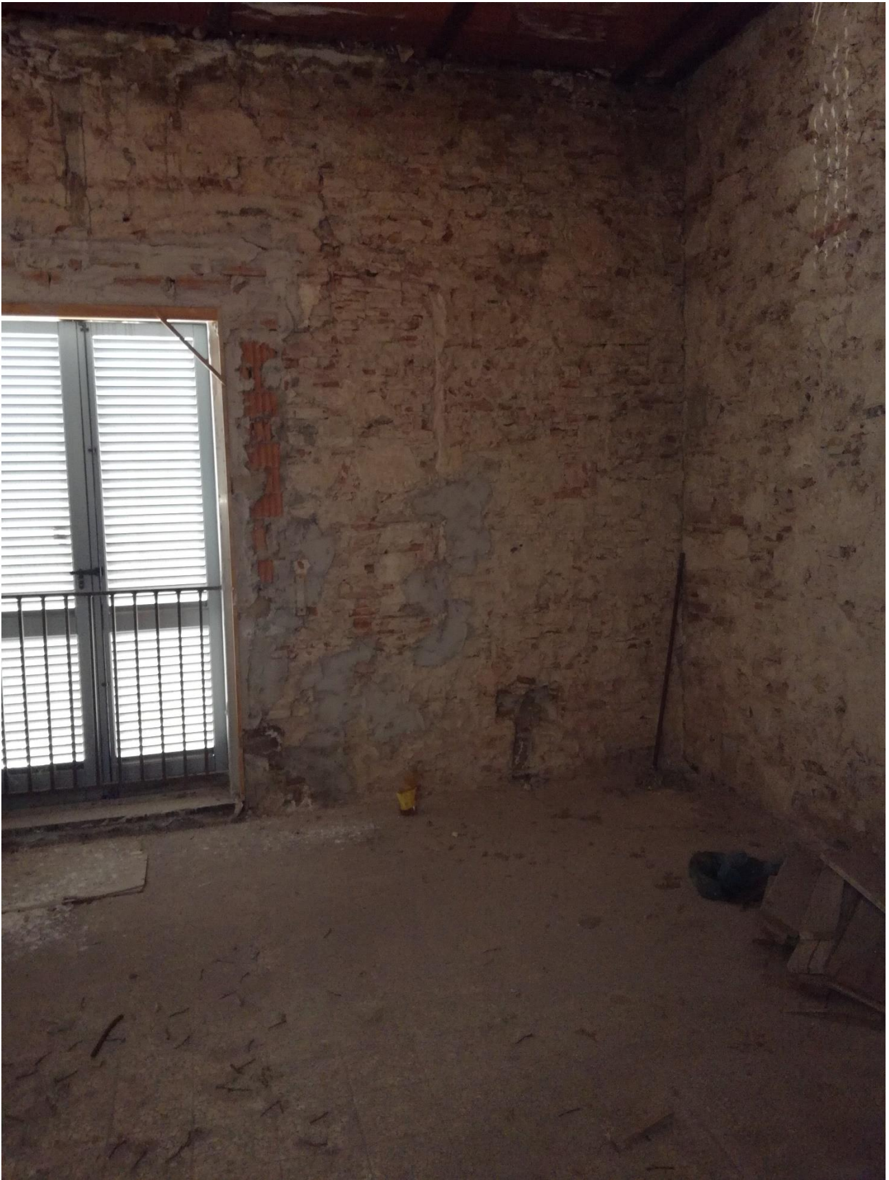
LOTTO 1 – P 1° - RISTRUTTURAZIONE INTERNA
