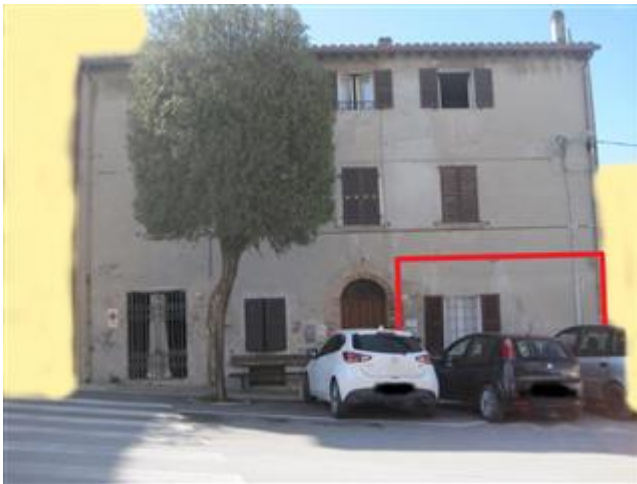
Prospetto fronte strada fabbricato con localizzazione dell'unità immobiliare oggetto di perizia
