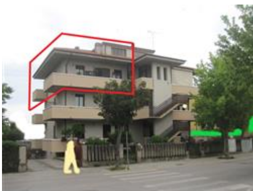
Prospetto fronte strada fabbricato con localizzazione dell'unità immobiliare oggetto di perizia
