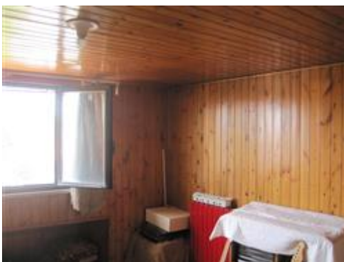
Interno 5 - Piano terzo sottotetto
