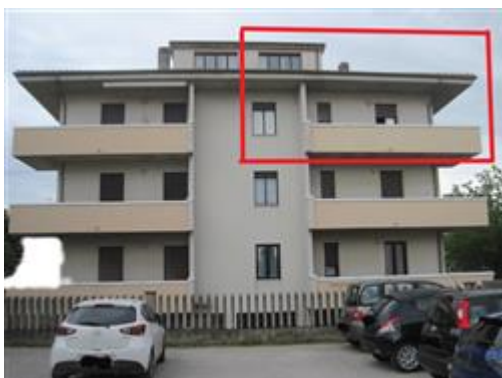
Retro prospetto fabbricato con localizzazione dell'unità immobiliare oggetto di perizia
