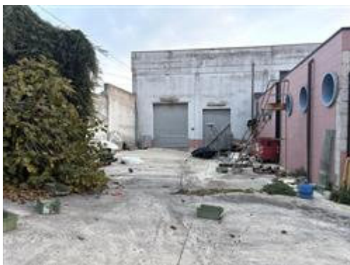
vista esterna ingresso garage
