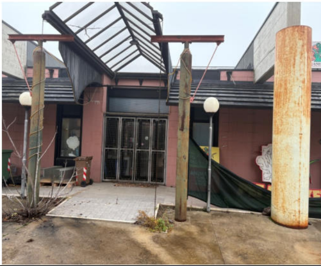
1- Ingresso principale negozio
