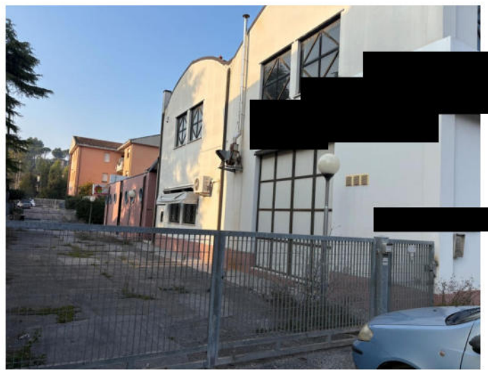
12 – ingresso pedonale uffici
