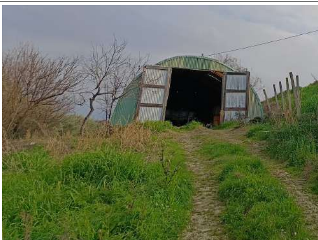
Accessori presenti sulla p.lla 294 f1-uso rimesse non facenti parte della perizia- prive di tipo edilizio
