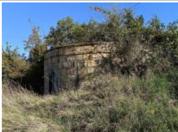
Cisterna di acqua in muratura
