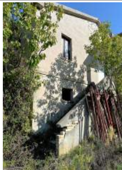
Particolare scala esterna - fronte sud
