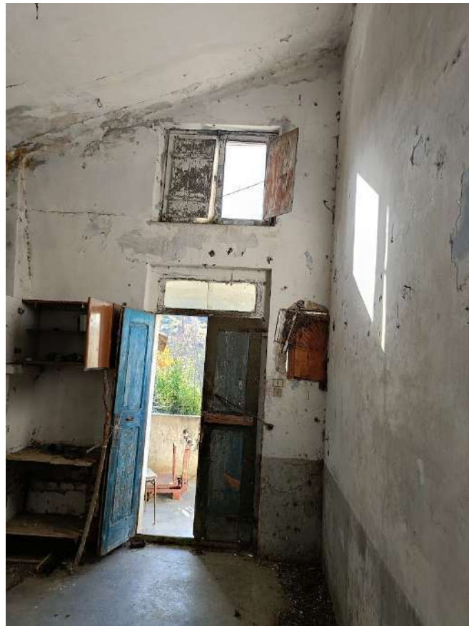
part ingresso con volume a tutta altezza
