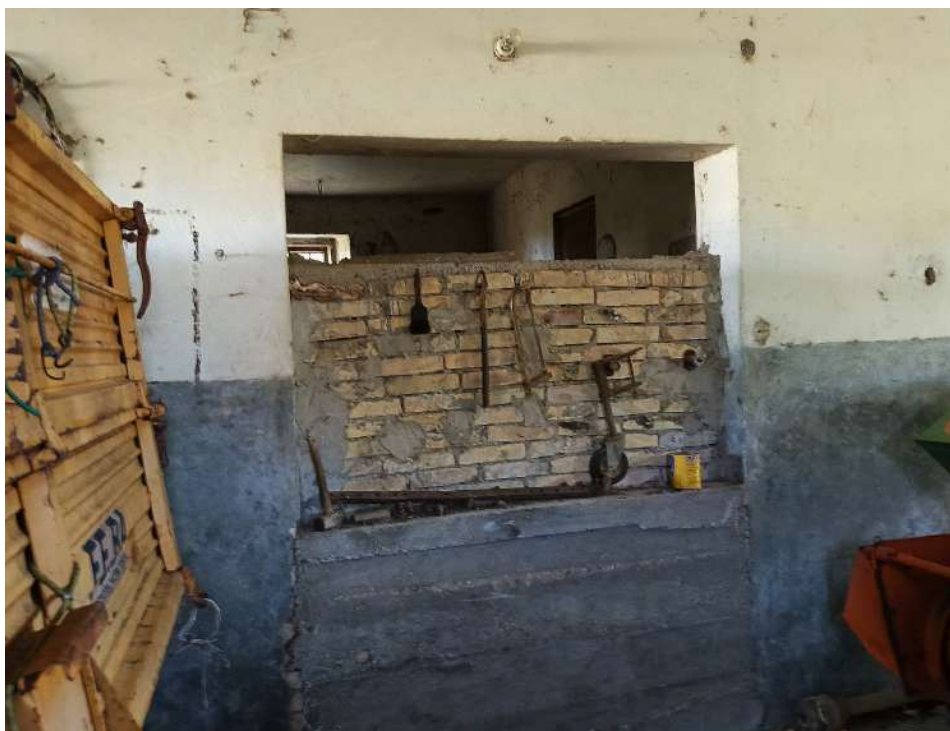
interno rimessa p.terra ex porta di collegamento
