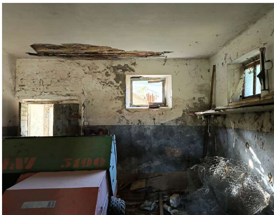
interno rimessa p.terra
