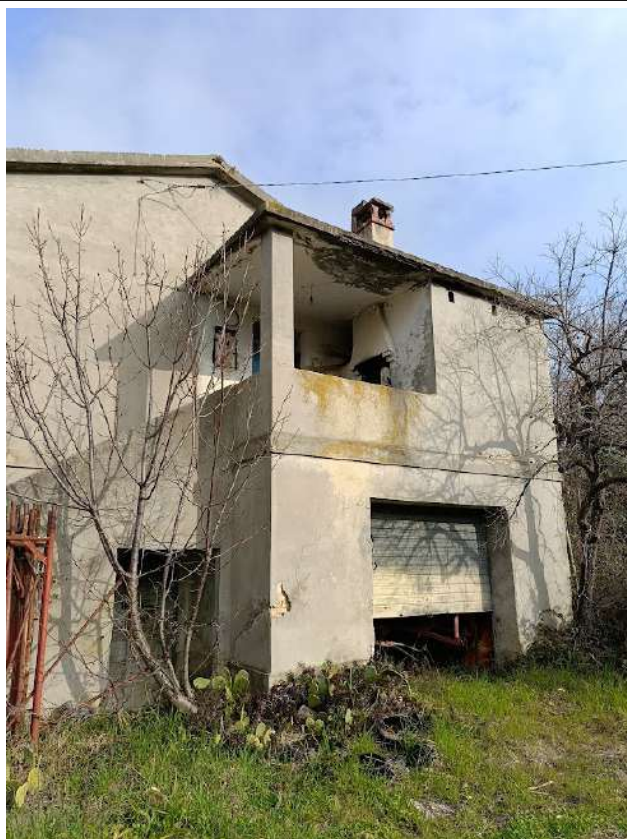
Fronte sud loggiato p1-rimessa est p.terra
