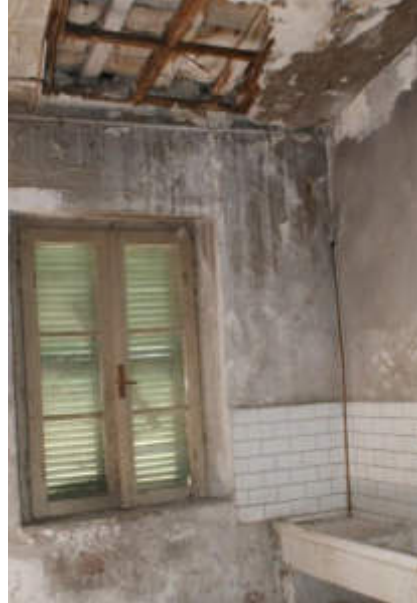
corpo C (part. 38, sub. 14 - casa colonica)
