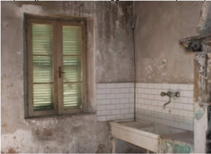
corpo C (part. 38, sub. 14 - casa colonica)
