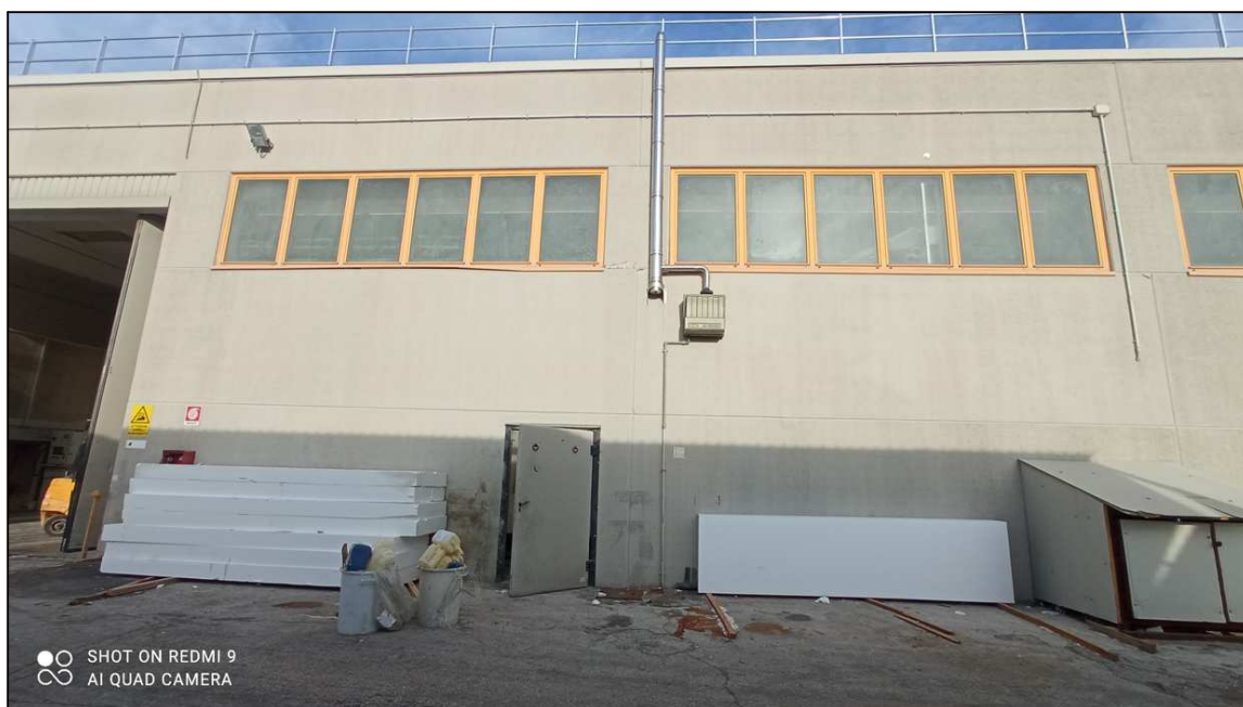
FOTO 5: PROSPETTO LATO LUNGO
