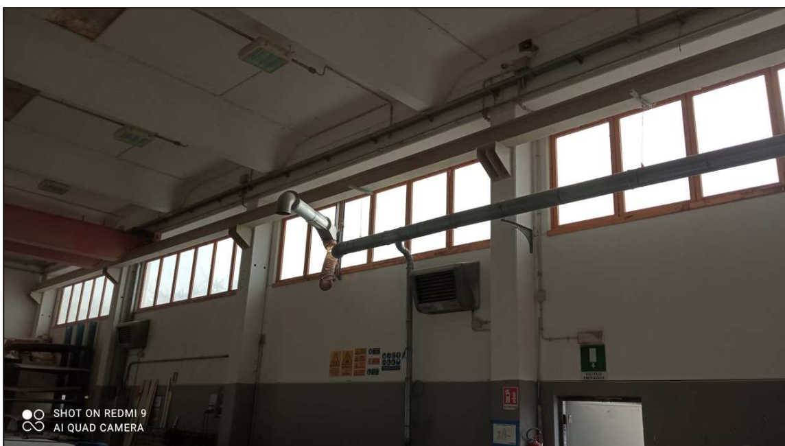
FOTO 12: SISTEMI DI ASPIRAZIONE
