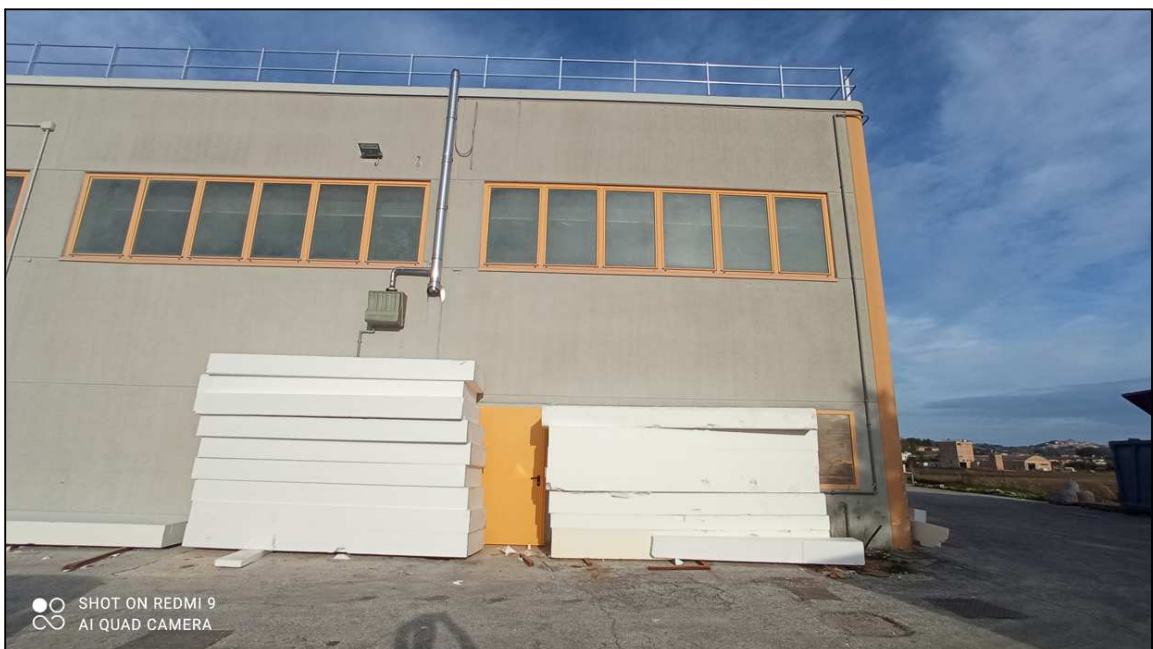
FOTO 3: PROSPETTO LATO LUNGO
