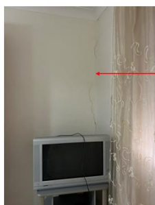
Foto n. 53 - Camera n.2 - particolare delle lesioni
