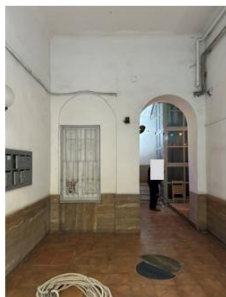
Foto n. 4 – Androne del fabbricato in cui è ubicato l'immobile pignorato
