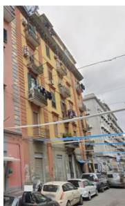
Foto n. 2 – Fabbricato in cui è ubicato l'immobile pignorato
