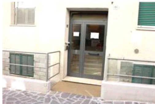
Panoramica ingresso edificio
