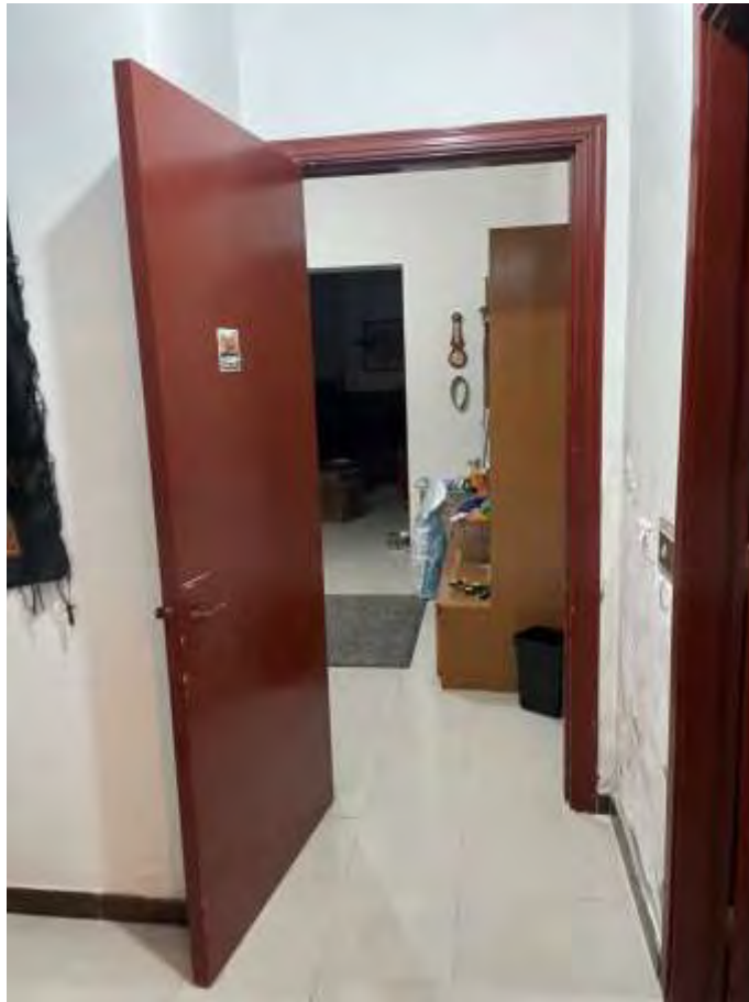
Foto n. 9 – Vista interna 'Disimpegno'
