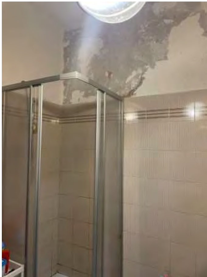
Foto n. 12 – Vista interna ‘Bagno’
