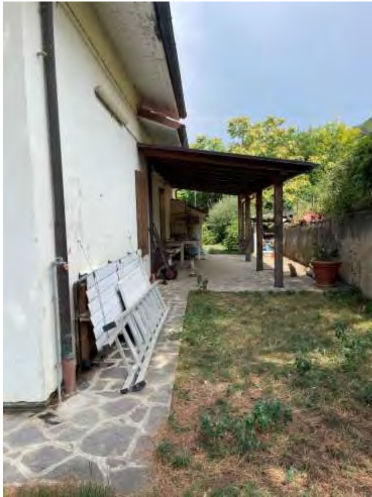
Foto n. D – Vista esterna Prospetto Nord-Est
