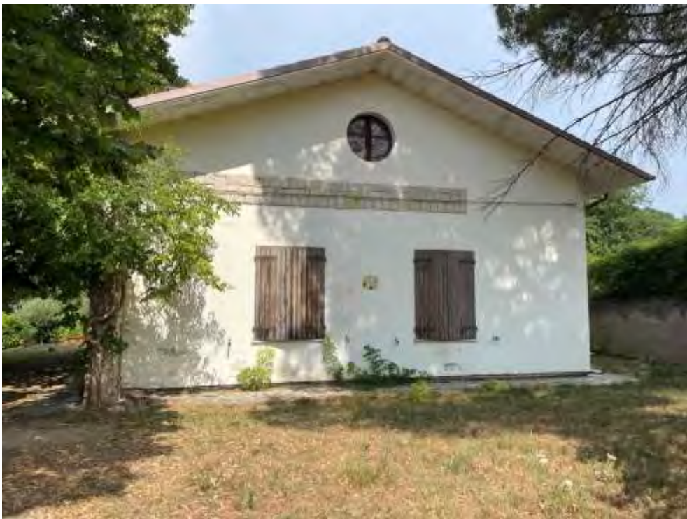
Foto n. C – Vista esterna Prospetto Sud-Est
