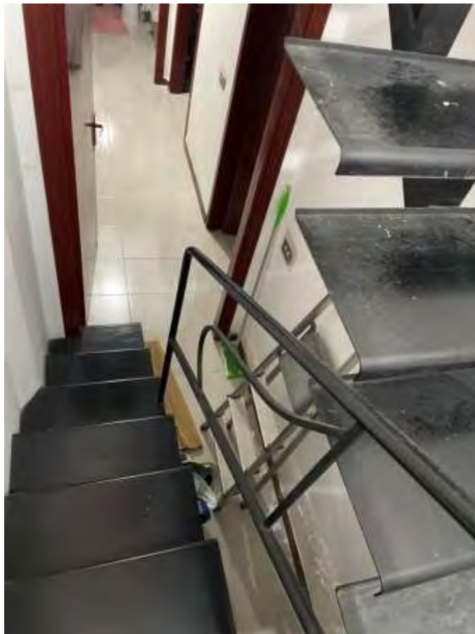
Foto n. 18 – Vista interna ‘Scala interna’
