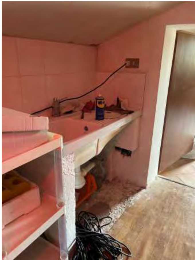
Foto n. 23 – Vista interna ‘Soffitta’
