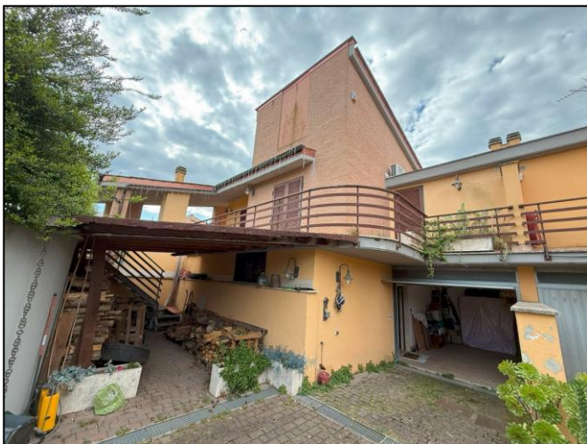
Vista esterna generica del fabbricato dal BCNC
