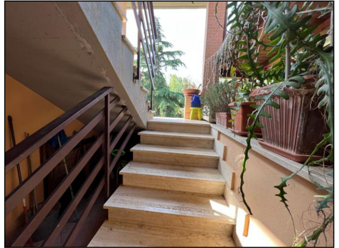
Accesso al giardino dal portico piano S1
