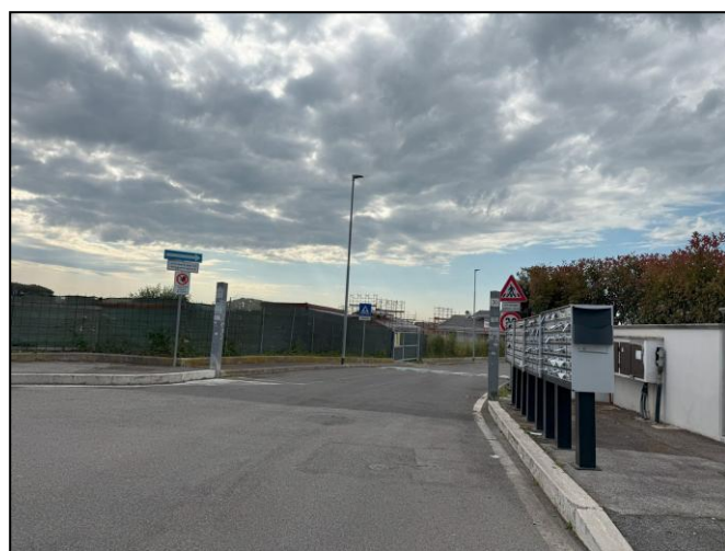
Ingresso alla strada consortile "Via Francesco Giacomo Tricomi 30"
