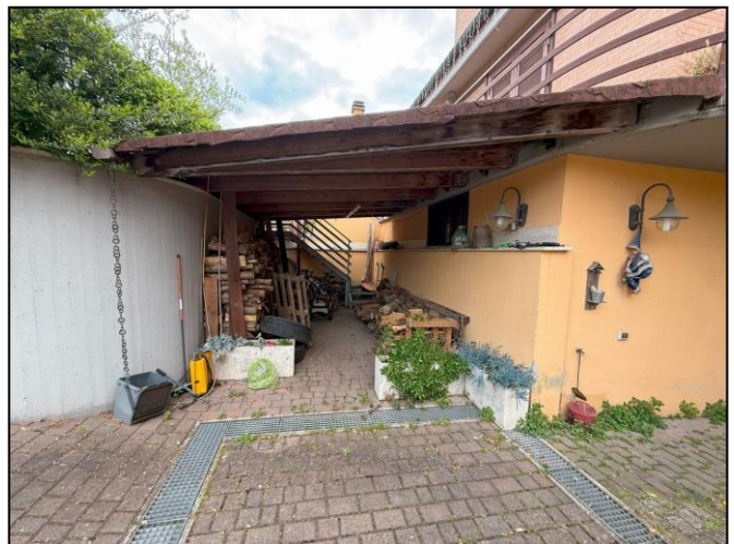
Posto auto con tettoia e scale di accesso al piano T
