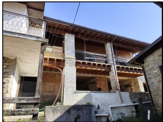
Prospetto sud del fabbricato
