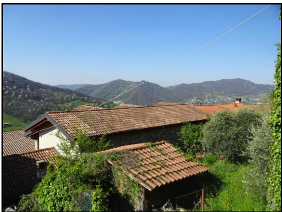
Prospetto nord e copertura del fabbricato
