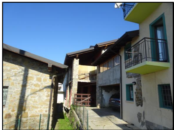
Prospetto est del fabbricato
