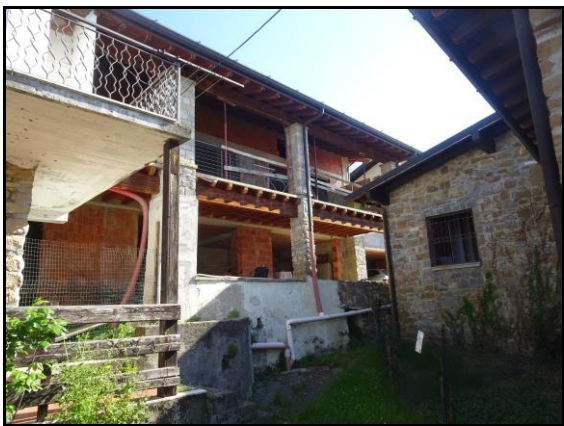
Prospetto sud del fabbricato
