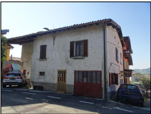
Vista da via Sella – prospetto nord
