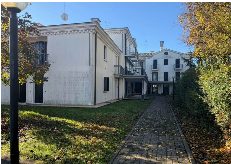
Foto n°1: vista del fabbricato condominiale da Sud-Est.
