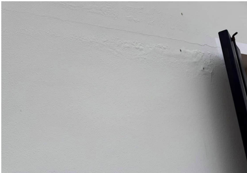
Foto n°11: particolare della parete esterna in corrispondenza del cordolo/ solaio intermedio tra piano primo/secondo.
