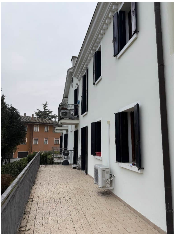
Foto n°9: porzione terrazza e facciata dell'appartamento (Nord-Est).
