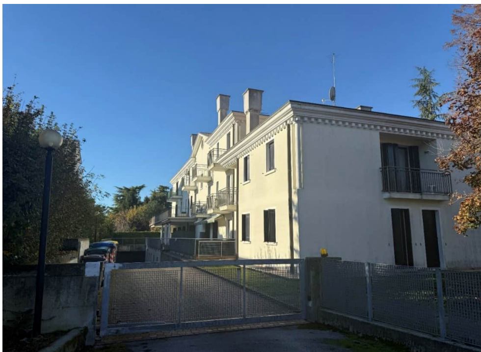
Foto n°2: vista del fabbricato condominiale da Sud-Ovest.
