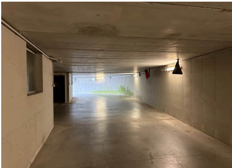
Foto n°21: corsia di manovra al piano interrato.
