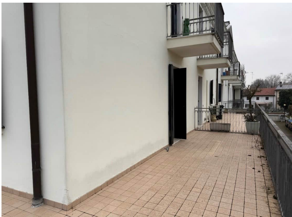
Foto n°10: porzione terrazza e facciata (Nord-Ovest).
