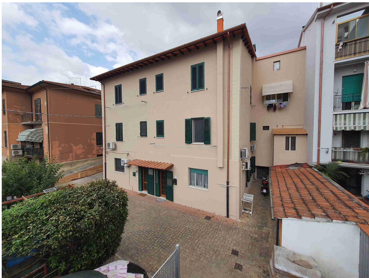
2. Vista esterna dall'angolo sud-ovest del maggior fabbricato
