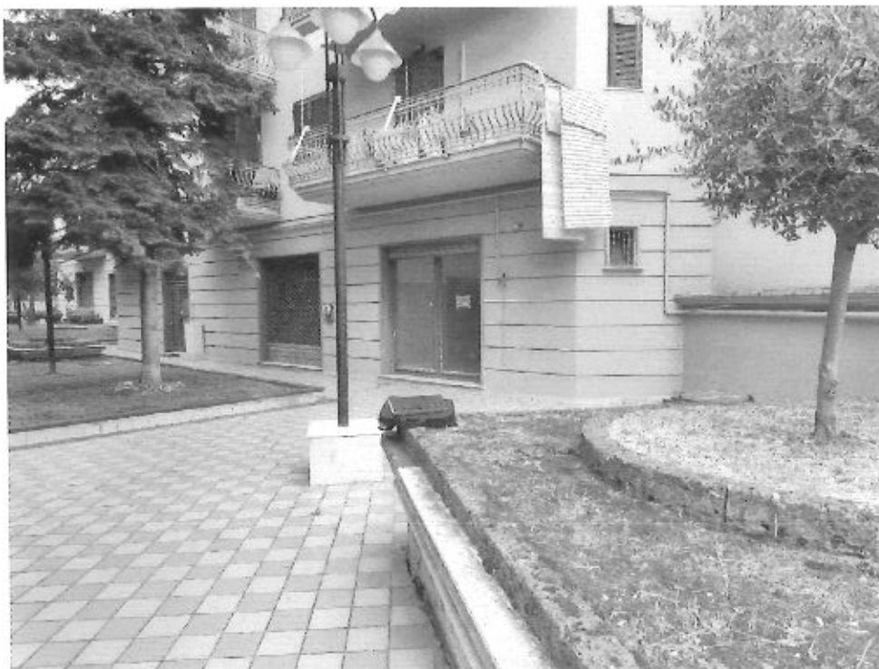
Foto N. 07 < Area pedonale di accesso al locale commerciale costituito da due grandi aperture vetrate posizionate frontalmente - Alleg. N. 03 >
