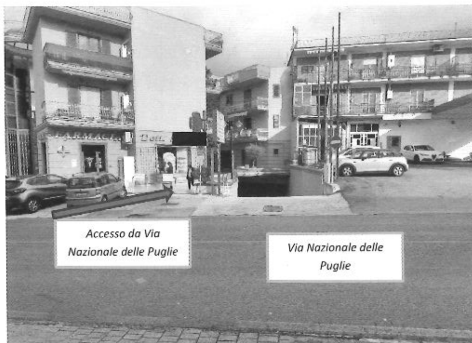
Foto N. 03 < Locale commerciale in oggetto posizionato frontalmente al piano terra sulla verticale della rampa di accesso garage - Via Nazionale delle Puglie - Complesso Parco delle Stelle Prezioso - Alleg. N. 03>
