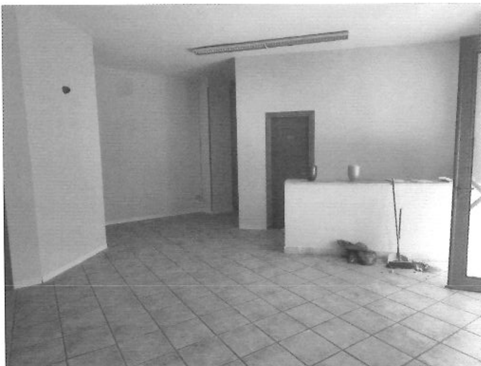
Foto N. 10 < Ambiente N. 1 - Ingresso del locale commerciale, frontalmente porta comunicante con Ambiente N.2- Alleg. N. 03>
