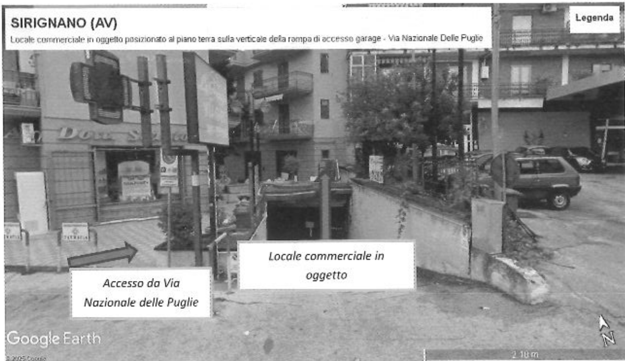
Foto N. 01_b < Rilievo satellitare – Locale commerciale in oggetto posizionato frontalmente al piano terra sulla verticale della rampa di accesso garage - Via Nazionale Delle Puglie – Complesso Parco delle Stelle Prezioso Alleg. N. 03>
