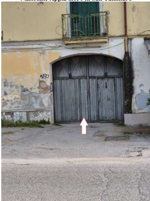
Figura 5 accesso al fabbricato a cui appartiene l'appartamento al primo piano pignorato ed accesso ai depositi al piano terra ed al terreno pavimentato pertinenziale
