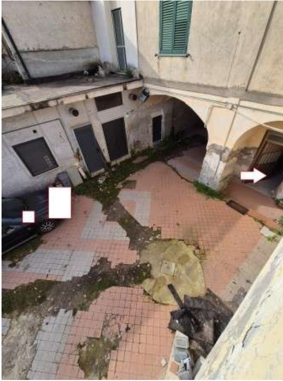
Figura 8 cortile comune con accesso al vano scala comune privi di ascensore
