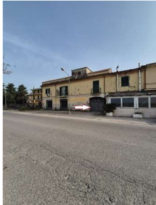
Figura 4 facciata ovest del fabbricato a cui appartiene l'appartamento al primo piano pignorato con accesso da via Nazionale Appia n.150 in San Tammaro
