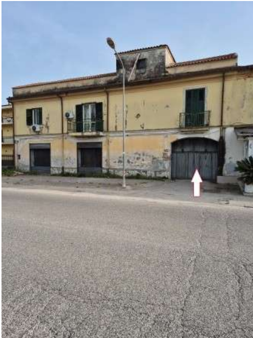
Figura 3 facciata ovest del fabbricato a cui appartiene l'appartamento al primo piano pignorato con accesso da via Nazionale Appia n.150 in San Tammaro
