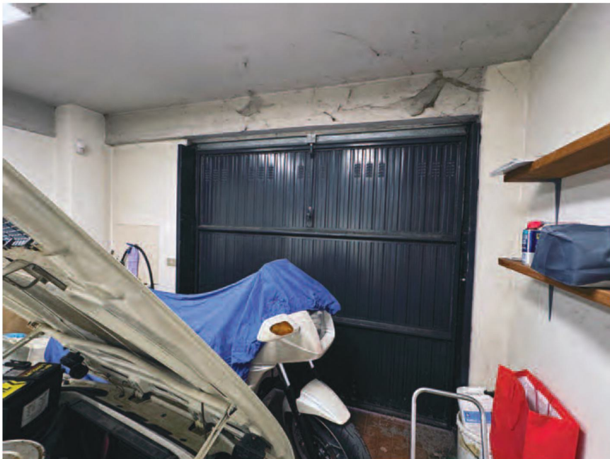
Foto 50 Vista dell'appartamento sito nel comune di Antrodoco (RI), via Giuseppe Mazzini n. 4, Piano 1, int. 4
