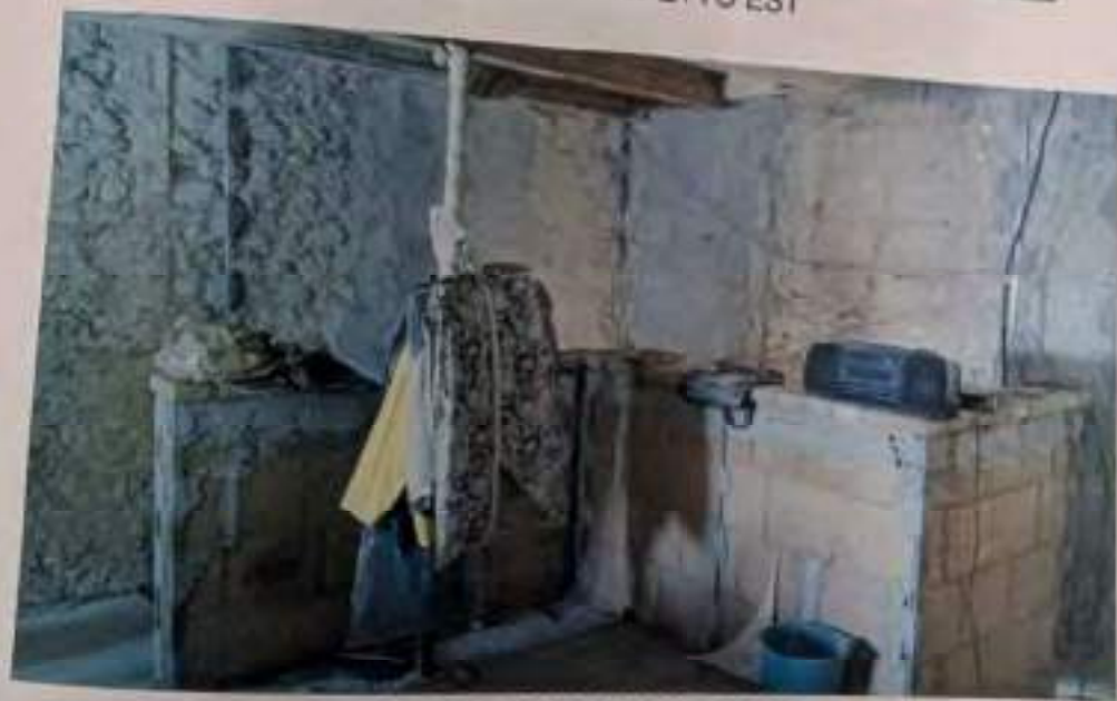
VISTA INTERNA PIANO PRIMO
