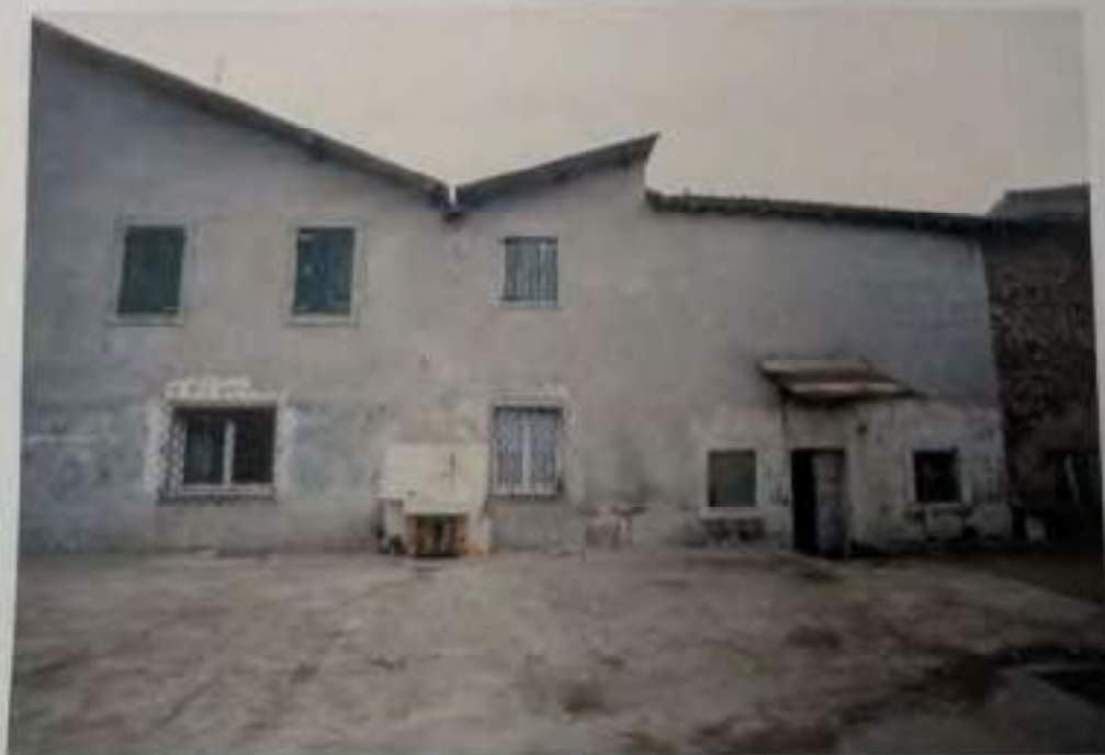
PROSPETTO NORD - foto 3
