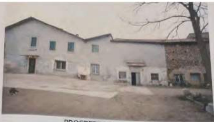
PROSPETTO NORD - foto 1
