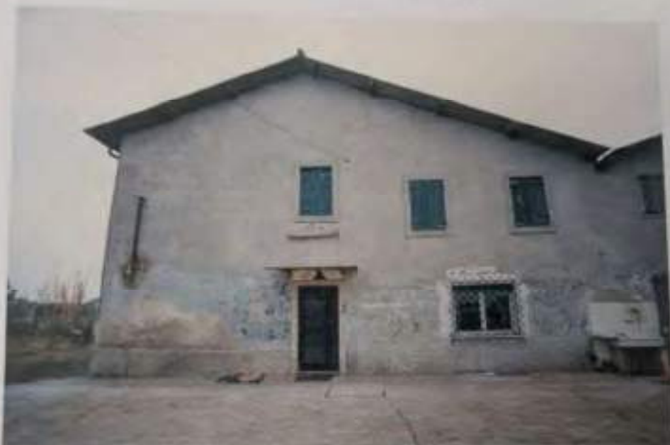
PROSPETTO NORD - foto 2
