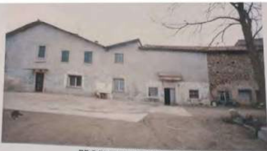
PROSPETTO NORD - foto 1
