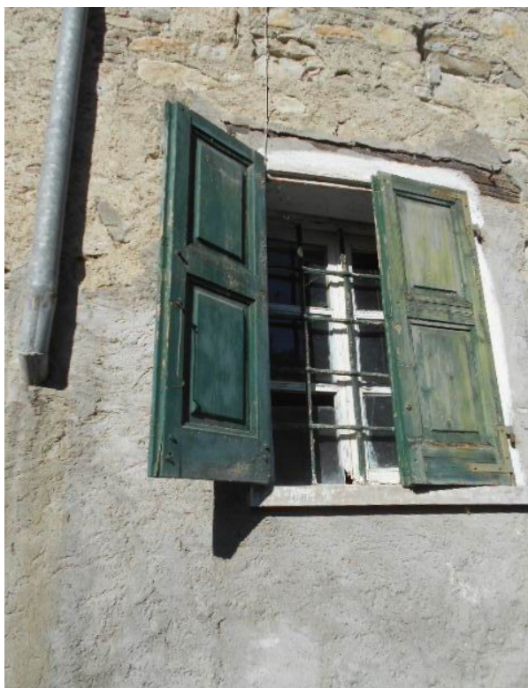
e finestra di piano terra
