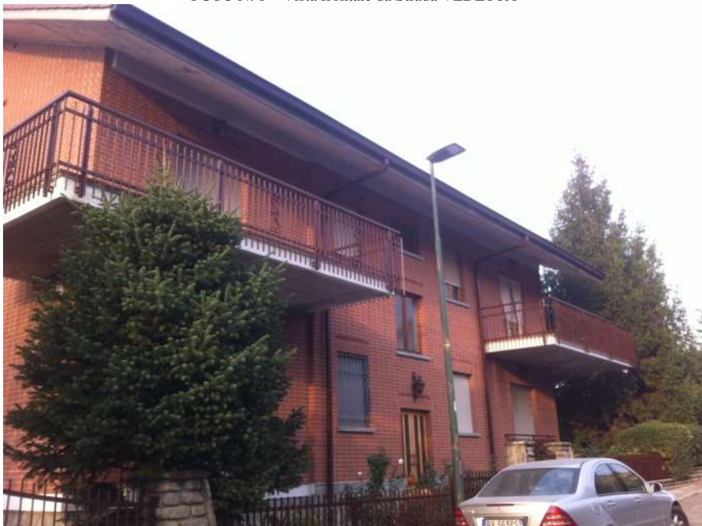
FOTO N. 1 – Vista frontale da Strada VEDETTA
