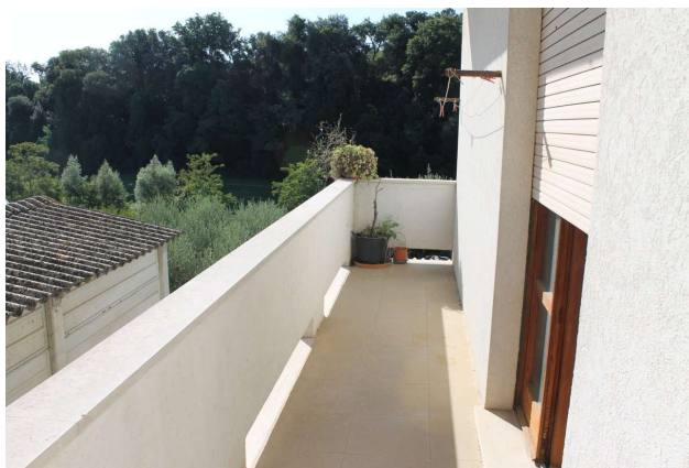
BALCONE LATO EST
