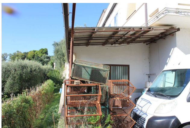
INGRESSO LATO EST
