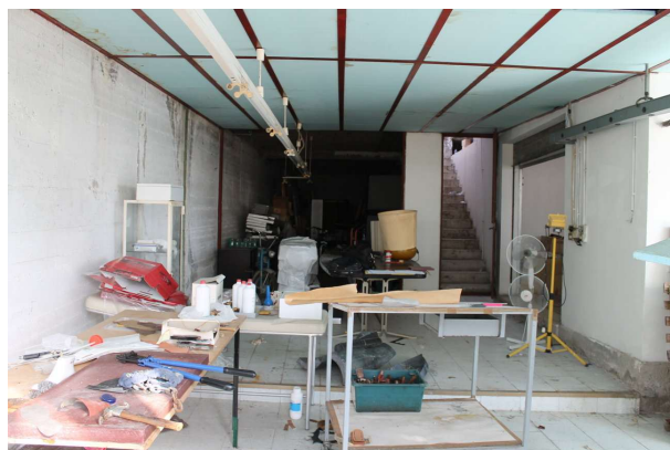
LOCALE DEPOSITO PS1 E SCALA DI COLLEGAMENTO AL CORTILE OVEST PT
