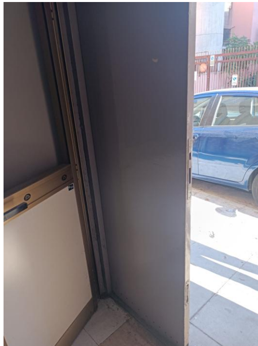
Foto 3: All'ingresso porta esterna in lamiera e interna in alluminio anodizzato
