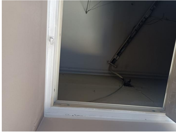
Foto 8: botola nel controsoffitto per accesso all'intercapedine
