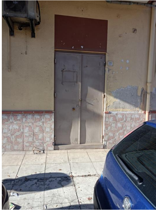
Foto 2: Ingresso al negozio dal marciapiede al civ. 77/A
