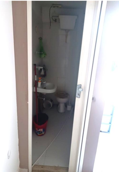
Foto 7: interno del vano del w.c.
