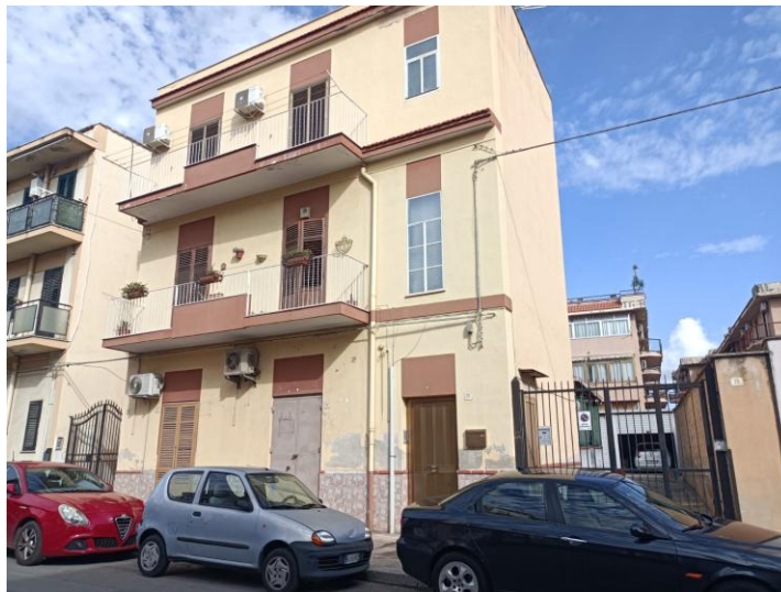
Foto 1: palazzina nella quale è ubicato il locale e ingresso dal marciapiede dal civ. 77/A (porta in ferro centrale)
