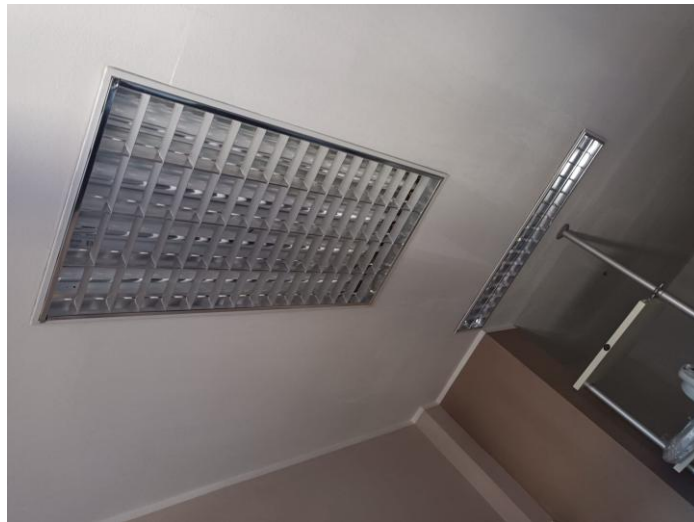
Foto 9: controsoffitto e griglie di areazione
