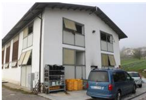
EDIFICIO STALLA PARTE A OVEST (ENTRATA)
