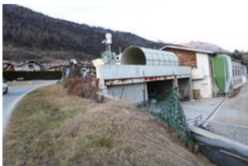
COMPENDIO VISTO DA SUD-OVEST
