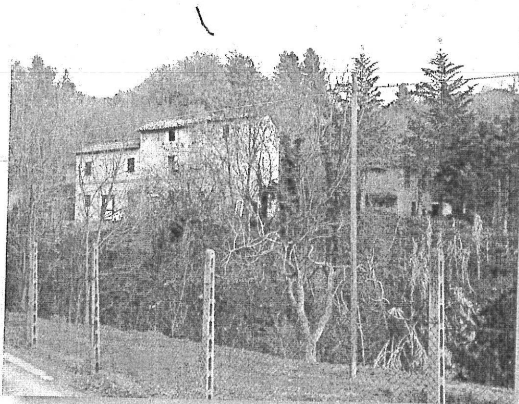
Veduta del fabbricato dalla strada di accesso.
