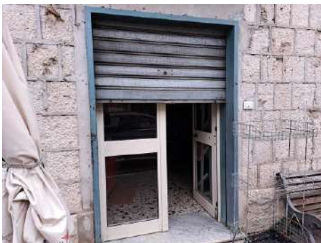
Foto 5: ... Locale fg. 10 p.IIa 1623 sub 3
