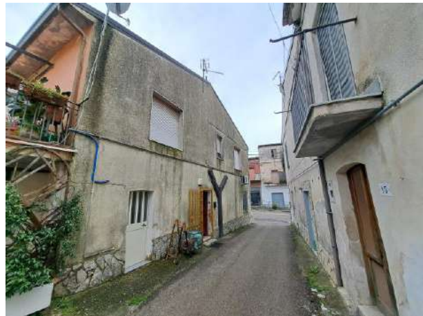
Foto 2: ... Fronte laterale sinistro
