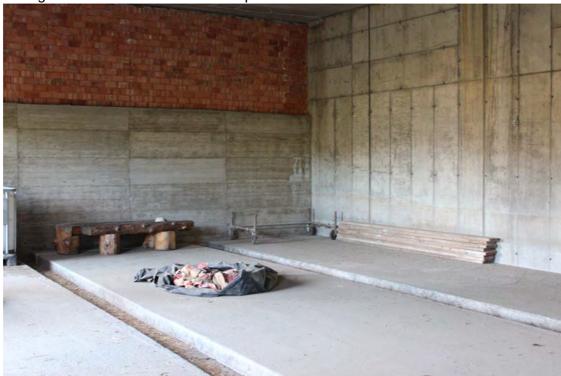
Fotogramma 6: vista dei locali del piano interrato da ultimare.
