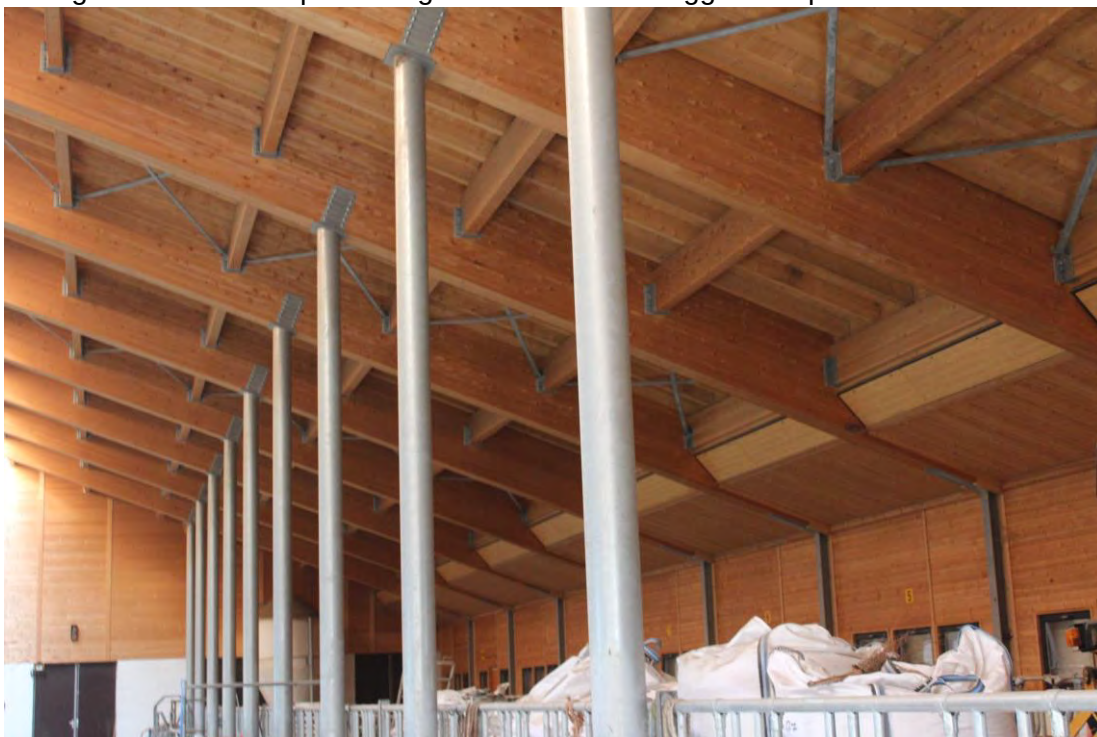
Fotogramma 4: la copertura lignea dell'immobile oggetto di perizia
