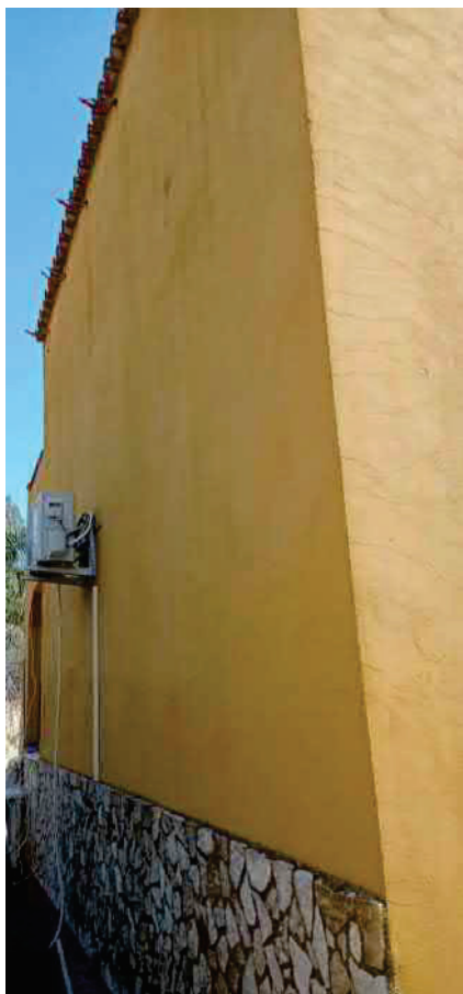
foto n.13 - prospetto ovest abitazione
