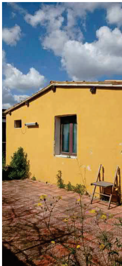
foto n.14 - prospetto est locale di sgombero
