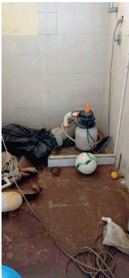
foto n 9 - wc piano terra
