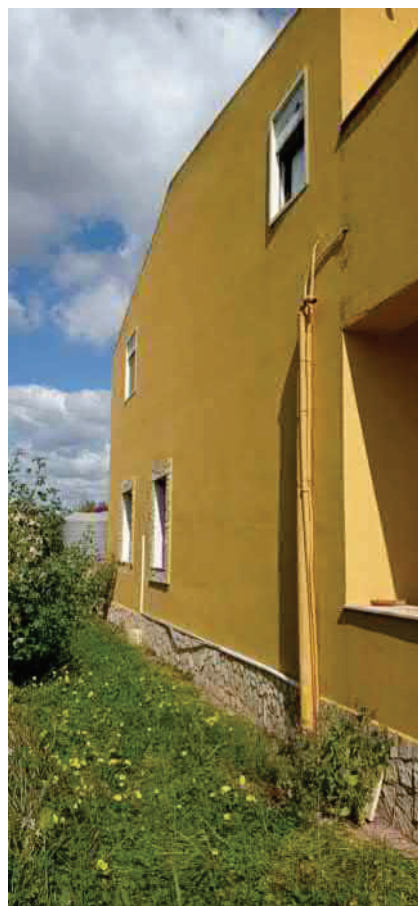
foto n.12 - prospetto sud abitazione
