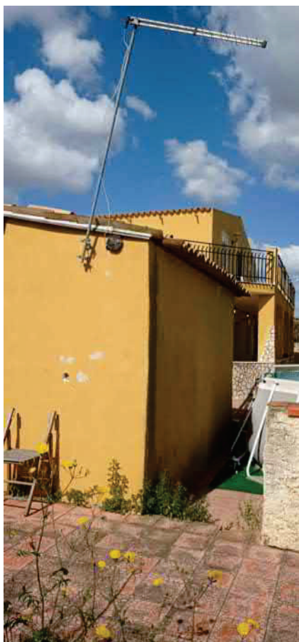
foto n.15 - prospetto nord locale di sgombero
