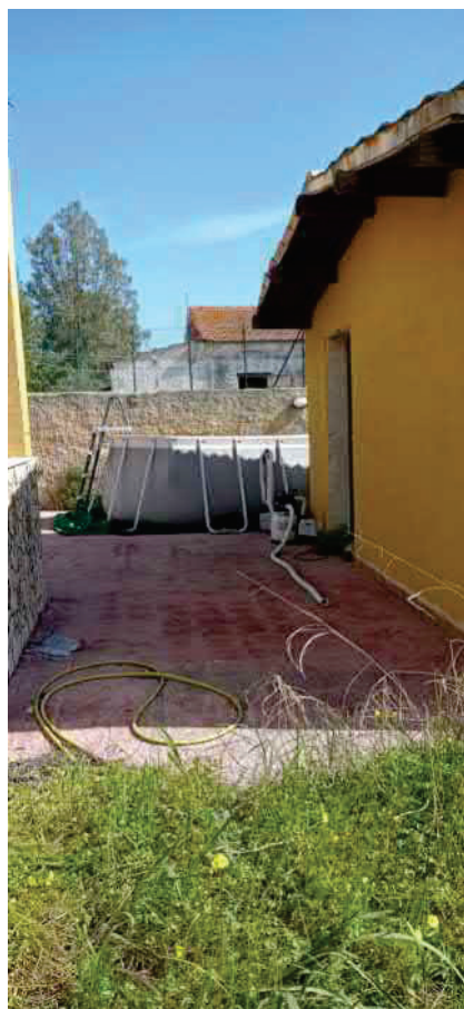
foto n.16 - prospetto ovest locale di sgombero
