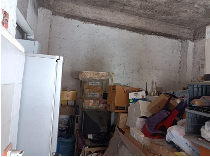
Foto 5: parete di fondo e struttura in c.a.
