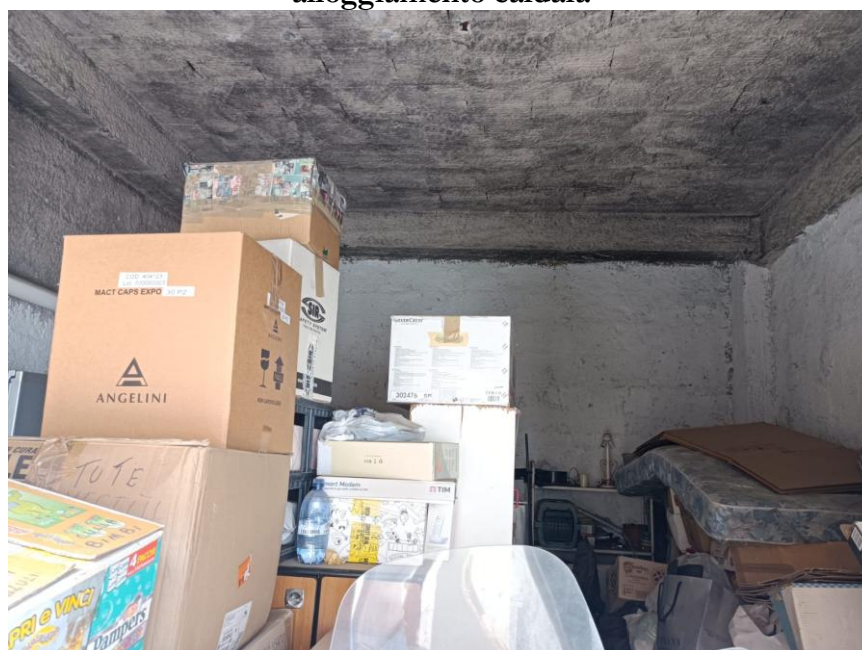
Foto 4: interno del magazzino: finitura al grezzo di pareti e soffitto
