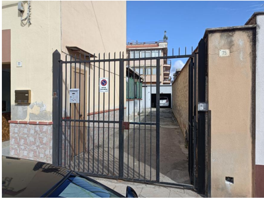
Foto 3: passaggio dal civ. 75 che consente un secondo ingresso all'appartamento
