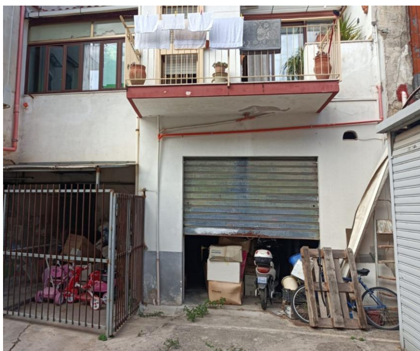
Foto 2: ingresso con saracinesca al magazzino dalla piccola corte comune
