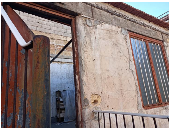
Foto 3: facciata di prospetto all'arrivo dalla scala a chiocciola
