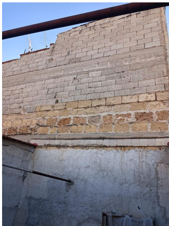
Foto 6: parete di fondo al confine con altra proprietà
