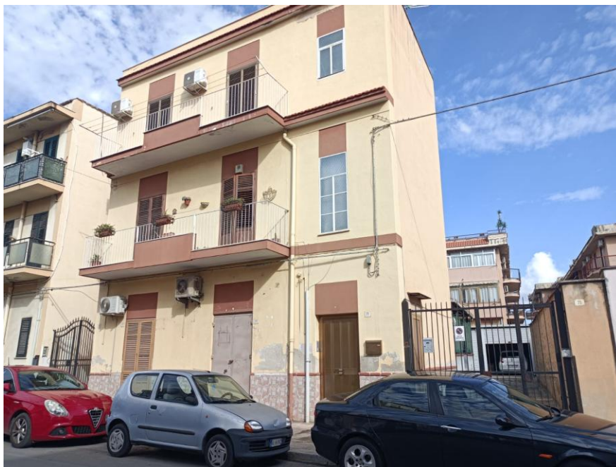
Foto 1: palazzina di ubicazione dell'appartamento
