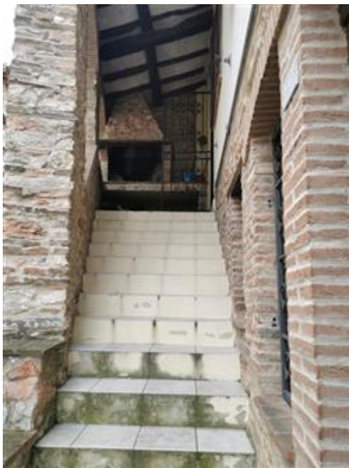
Scala ingresso esterno
