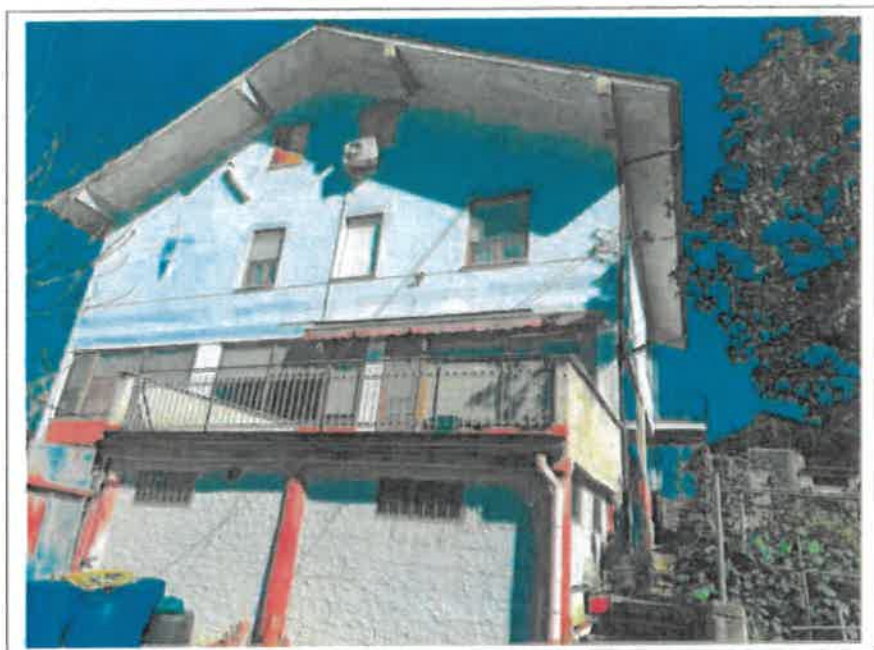
Foto n. 3 = Vista retro immobile in oggetto = Porzione da regolarizzare
