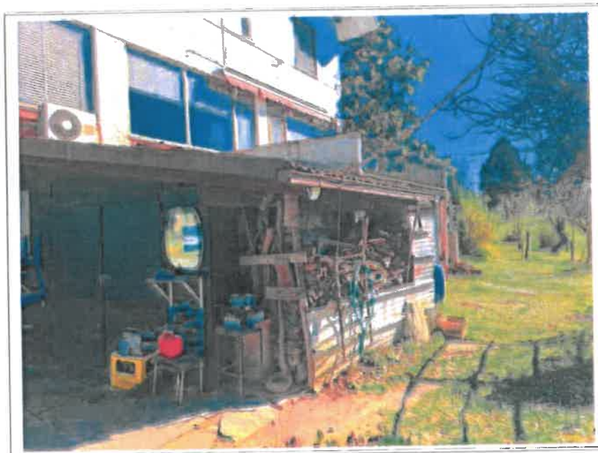
Foto n. 2 = Vista retro immobile in oggetto = Porzione da regolarizzare
