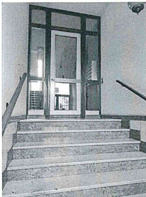
Scala d'accesso al vano scala (p. rialzato)
