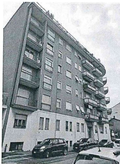
Vista condominio da Via Legnano
