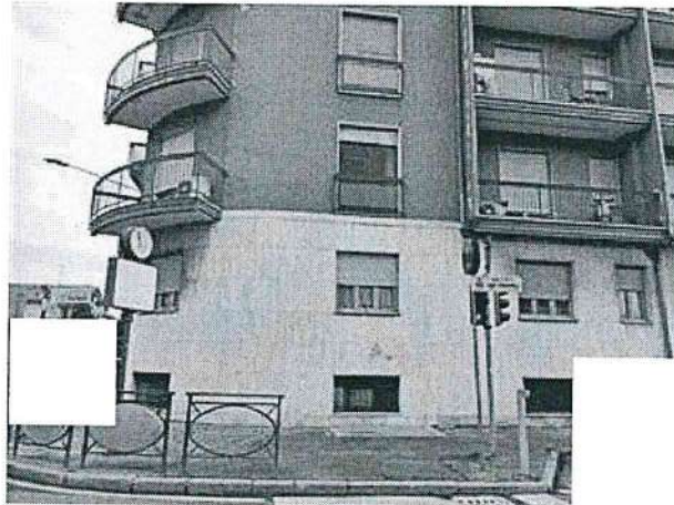
Vista esterna unità abitativa al piano rialzato (lato via Battisti)
