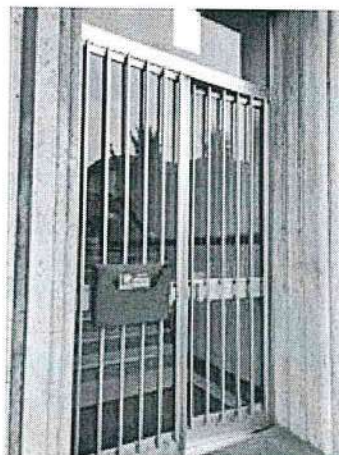
Portone d'ingresso al vano scala (Via Legnano 8)
