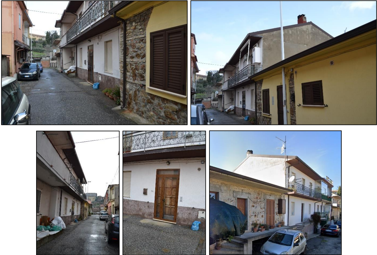
Figura 6 - Vista di insieme del fabbricato
