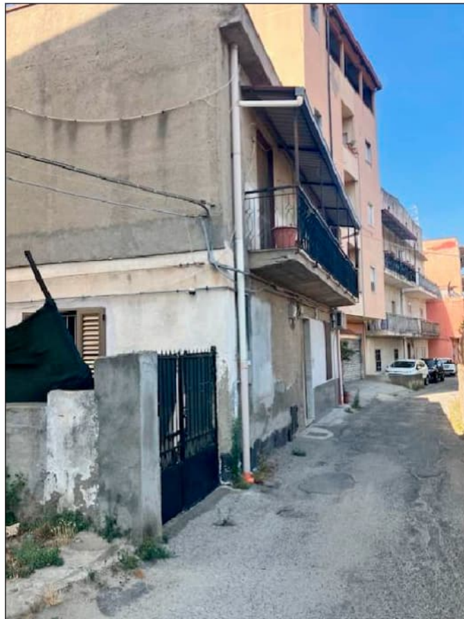
Accesso dal vano scala condominiale
