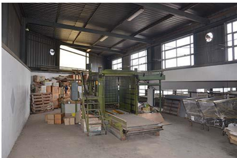
imm2.52: deposito (tratto a sud)
