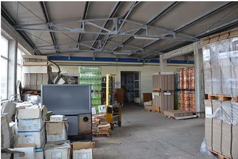
imm2.51: capannone (sub 2)
