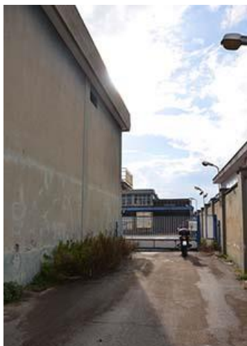
imm2.07: ingresso al piazzale
