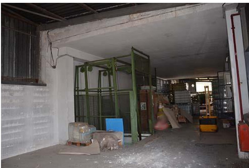
imm2.49: scala di servizio con montacarichi
