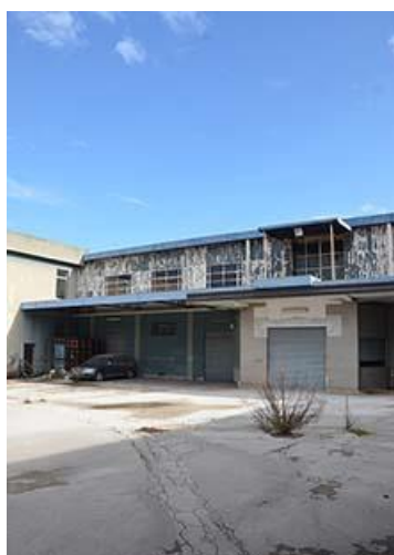
imm2.09: viste dal piazzale interno
