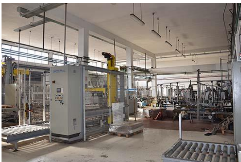
imm2.22: sala lavorazione corpo di fabbrica C
