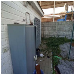
FOTO 9 - VISTA ESTERNA AL LOCALE TECNICO
