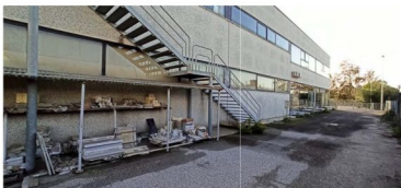
FOTO 26 - VISTA FABBRICATO 1 - DETTAGLIO TETTOIA 2
