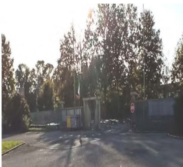
FOTO 3 - INGRESSI CARRABILI - VISTA DALL'INTERNO
