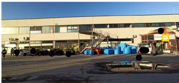
FOTO 22 – VISTA FABBRICATO 1 DALLA CORTE ESCLUSIVA
