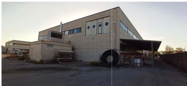
FOTO 28 - VISTA FABBRICATO 1 DALLA CORTE ESCLUSIVA
