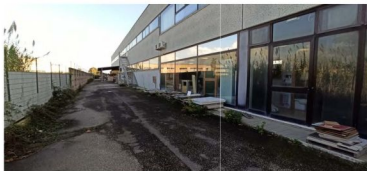
FOTO 24 – VISTA FABBRICATO 1 DALLA CORTE ESCLUSIVA
