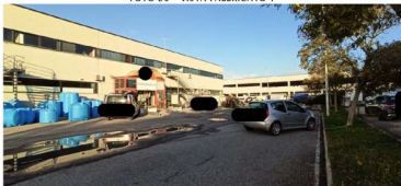
FOTO 21 - VISTA FABBRICATO I DALLA CORTE ESCLUSIVA
