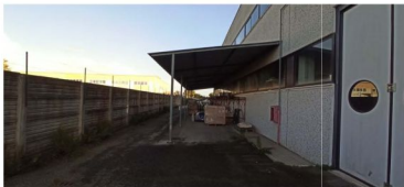
FOTO 25 - VISTA FABBRICATO 1 - DETTAGLIO TETTOIA 1
