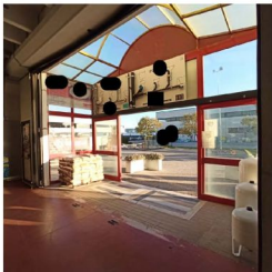
FOTO 38 – INGRESSO CON STRUTTURA A VETRO E ALLUMINIO
