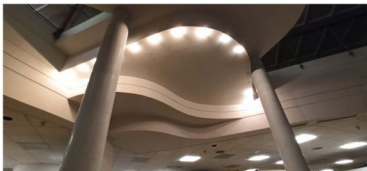
FOTO 43 - DETTAGLIO CONTROSOFFITTO SCALINATA
