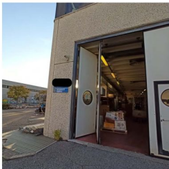
FOTO 34 – VISTA FABBRICATO – DETTAGLIO INGRESSO MAGAZZINI
