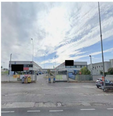
FOTO 4 - INGRESSI CARRABILI - VISTA DA VIA NETTUNENSE
