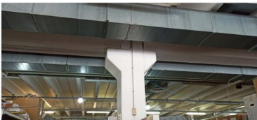
FOTO 72 - DETTAGLIO STRUTTURA PREFABBRICATA CLS
