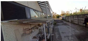
FOTO 27 - VISTA FABBRICATO 1 - DETTAGLIO TETTOIA 2
