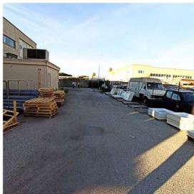
FOTO 31 - CORTE ESCLUSIVA RETROSTANTE IL FABBRICATO
