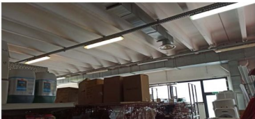
FOTO 73 - DETTAGLIO SOLAI PREFABBRICATI CLS
