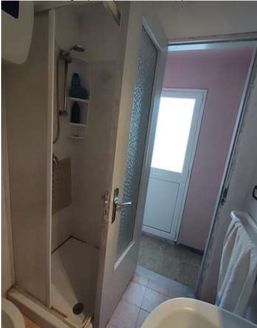
Foto 35 – Lotto unico – Bagno piano primo fabbricato particella 614
