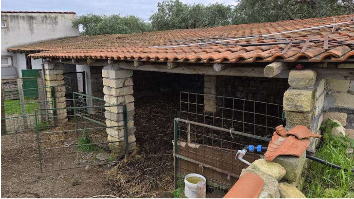
Foto 50 – Lotto unico – Tettoia 1 particella 184
