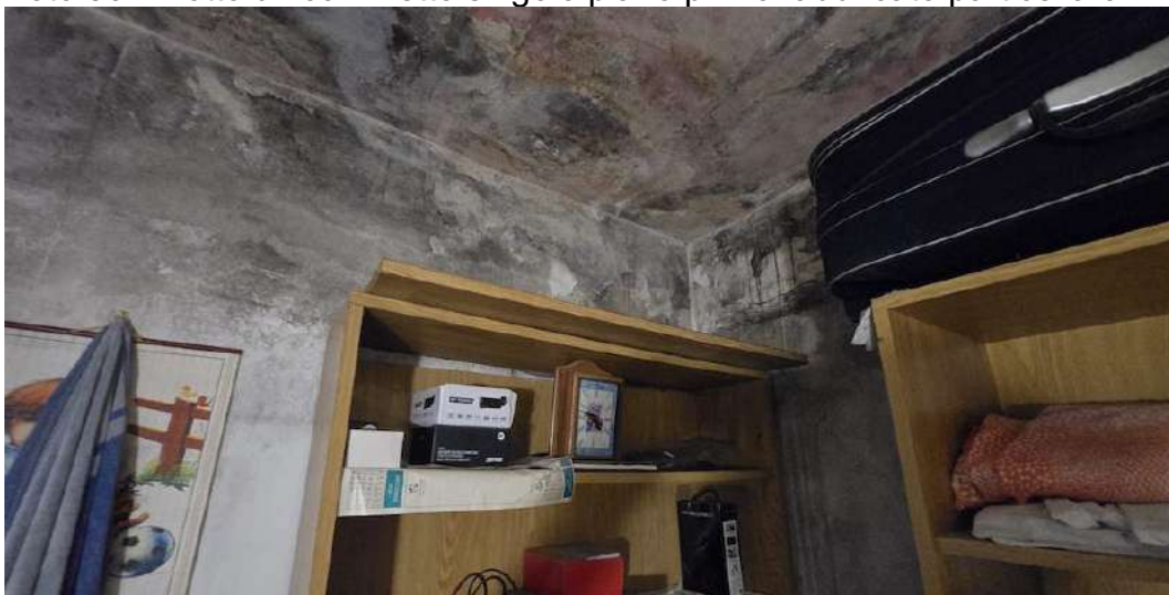
Foto 37 – Lotto unico – Letto singolo piano primo fabbricato particella 614
