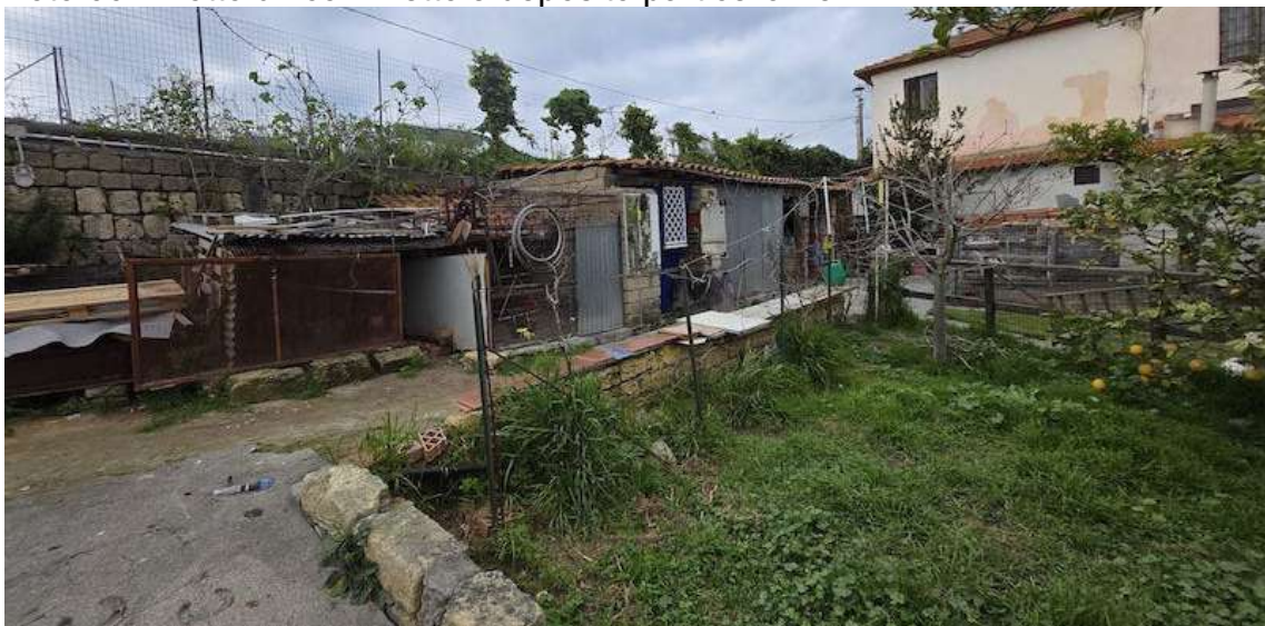
Foto 67 – Lotto unico – Tettoie deposito particella 184
