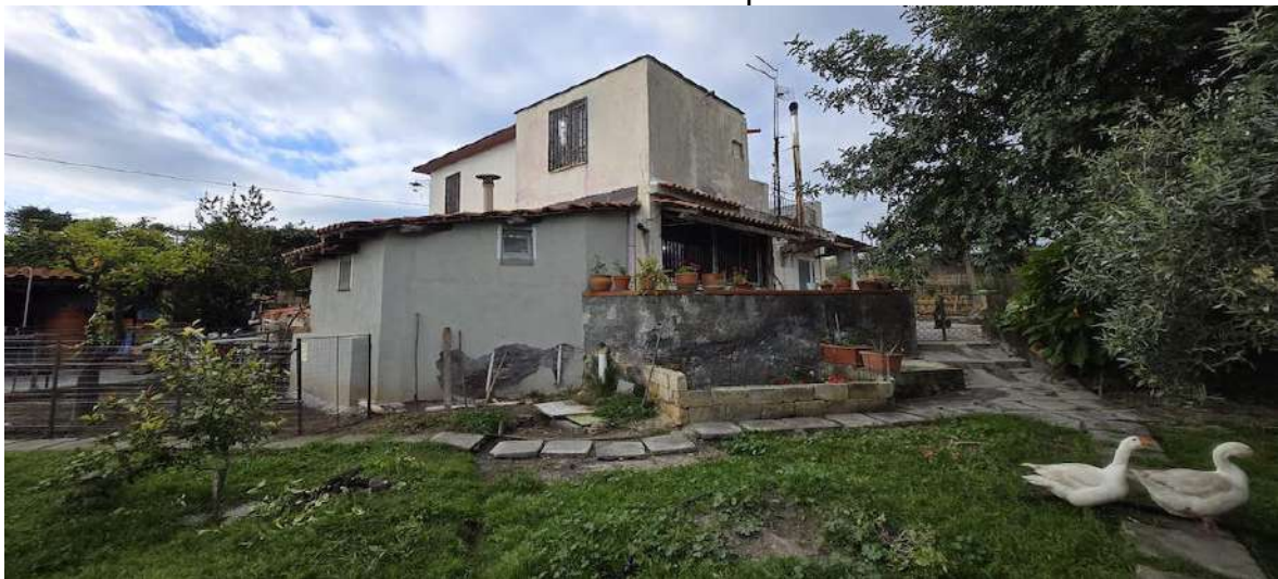
Foto 17 – Lotto unico – Vista esterna fabbricato particella 614
