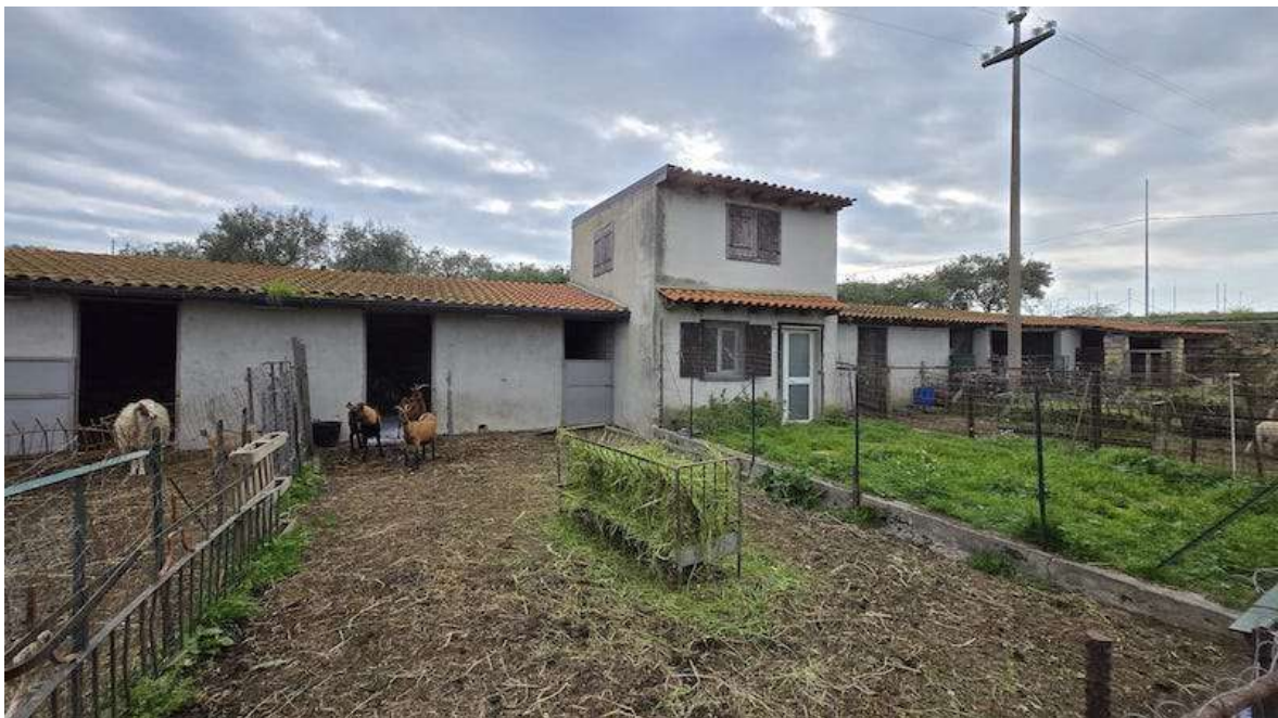
Foto 55 – Lotto unico – Tettoie 4, 5, 6 e fabbricato in abuso particella 184
