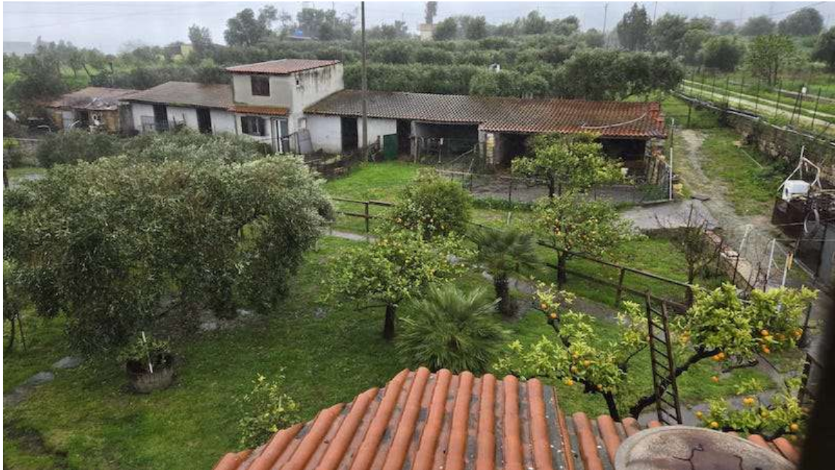
Foto 48 – Lotto unico – Panoramica tettoie e fabbricato in abuso particella 184
