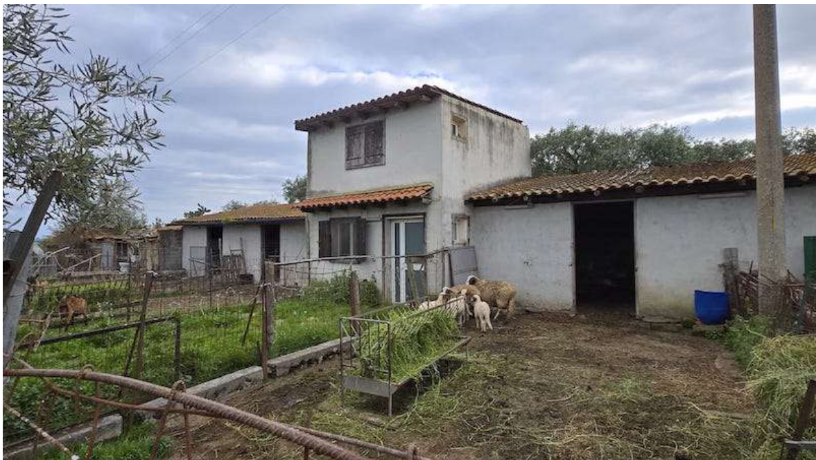
Foto 53 – Lotto unico – Fabbricato in abuso e tettoie 1, 2, 3 particella 184
