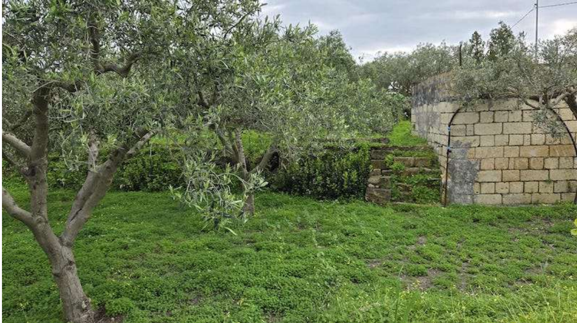
Foto 73 – Lotto unico – Uliveto e vasca raccolta acqua particella 184
