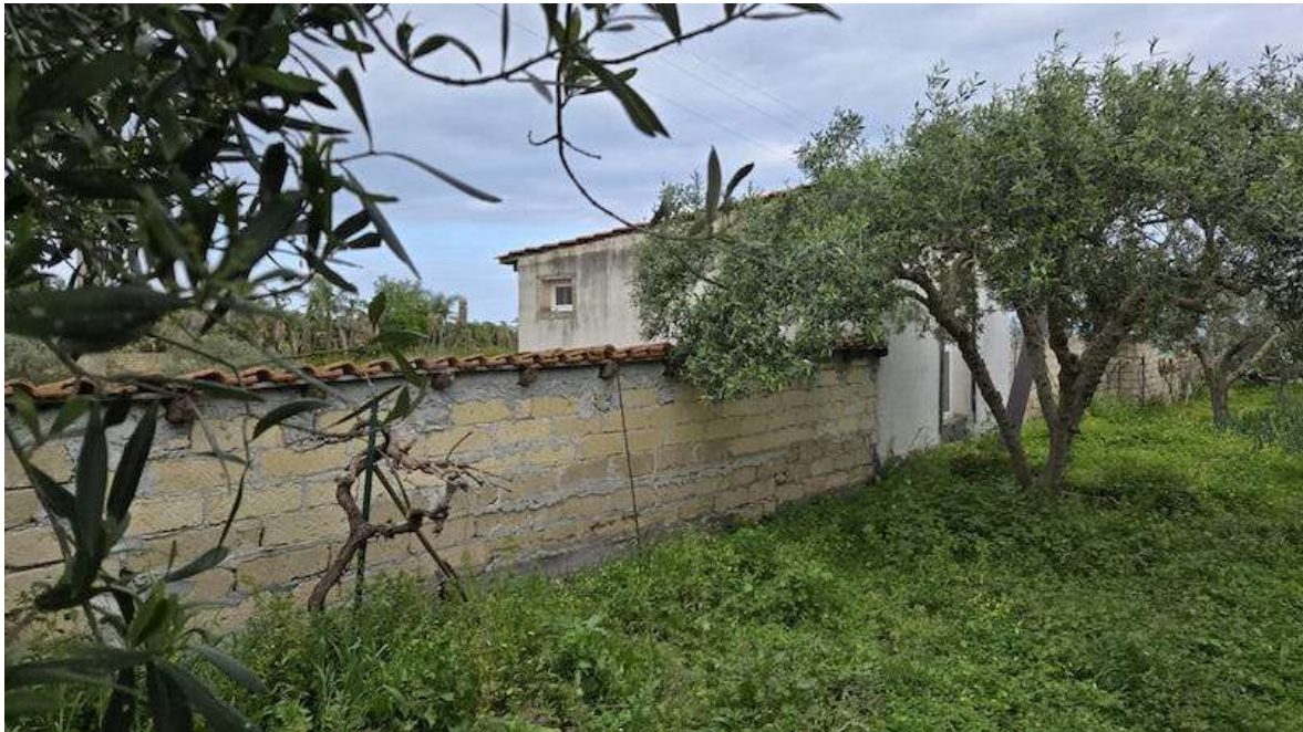
Foto 61 – Lotto unico – Fabbricato in abuso piano terra particella 184
