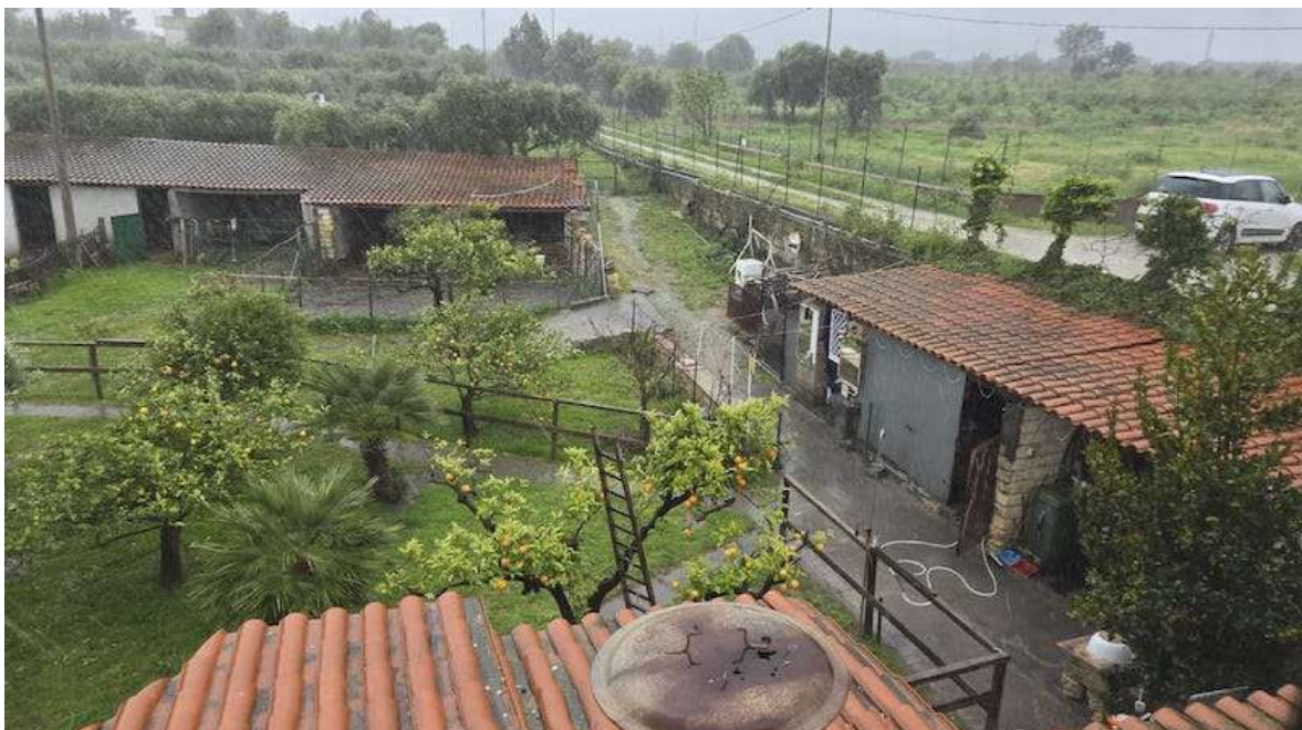
Foto 47 – Lotto unico – Panoramica tettoie e fabbricato in abuso particella 184
