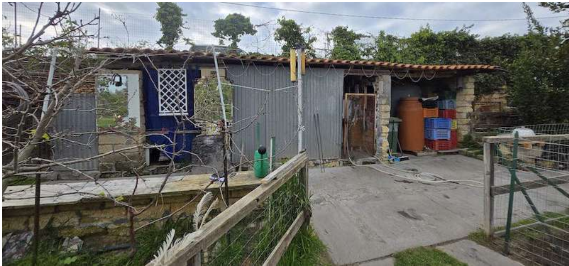
Foto 65 – Lotto unico – Tettoie deposito particella 184
