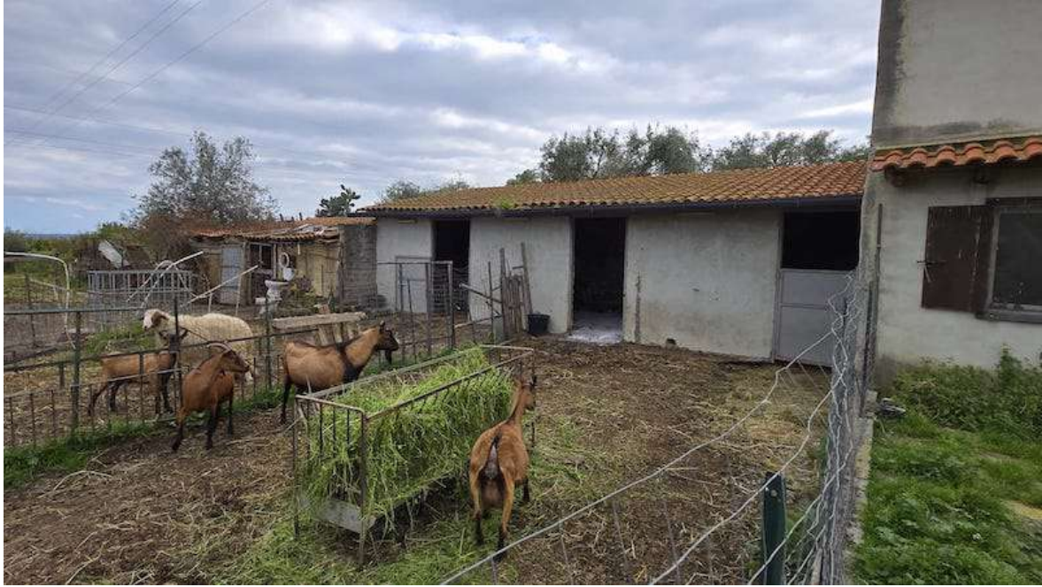
Foto 56 – Lotto unico – Tettoie 4, 5, 6 particella 184
