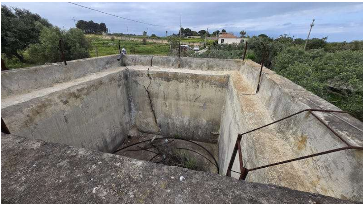
Foto 74 – Lotto unico – Vasca raccolta acqua particella 184
