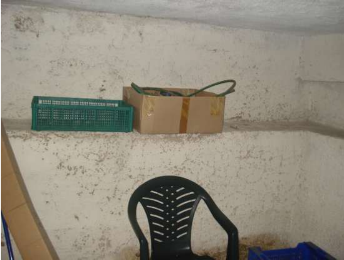
FOTO n° 13: Altro particolare del vano cantina.
