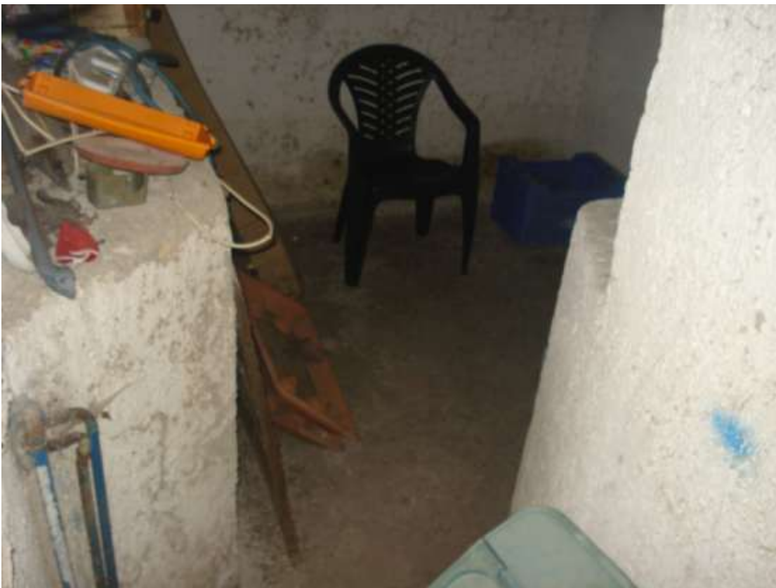
FOTO n° 12: Particolare del vano cantina, completamente allo stato grezzo.
