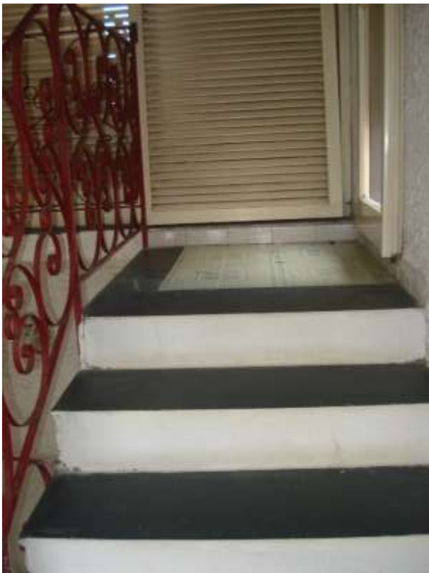
FOTO n° 42 : Particolare dell'arrivo della scala al piano terrazzo e copertura.
