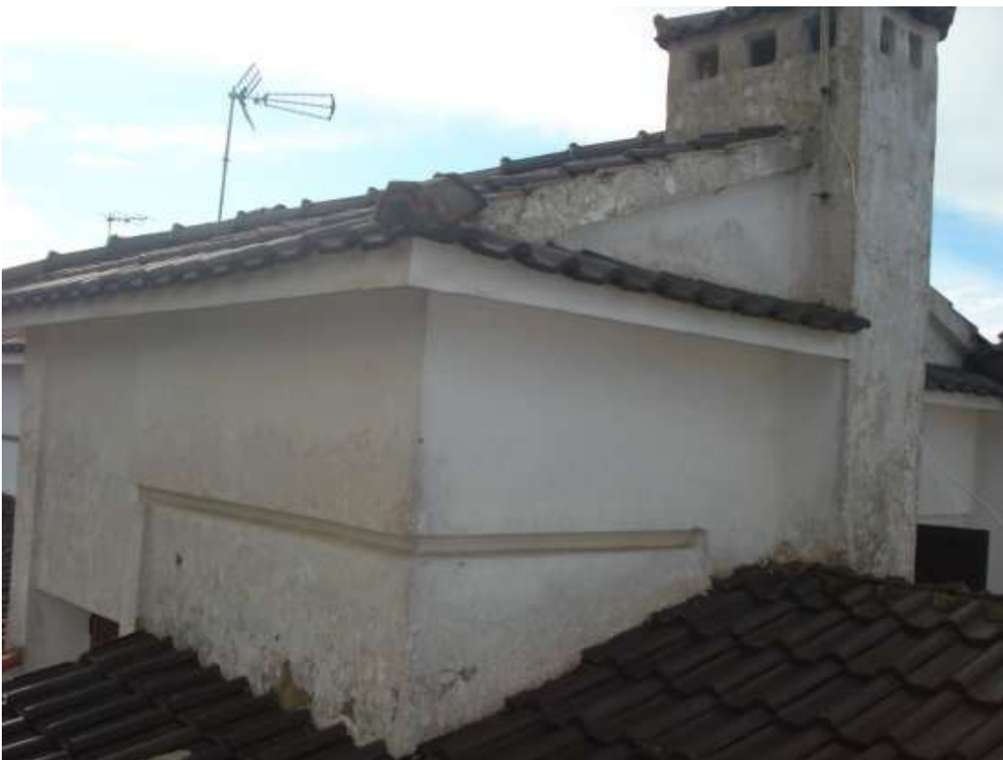
FOTO n° 52 : Vista dell'a parte alta delle falde del tetto ripresa dal colmo basso
