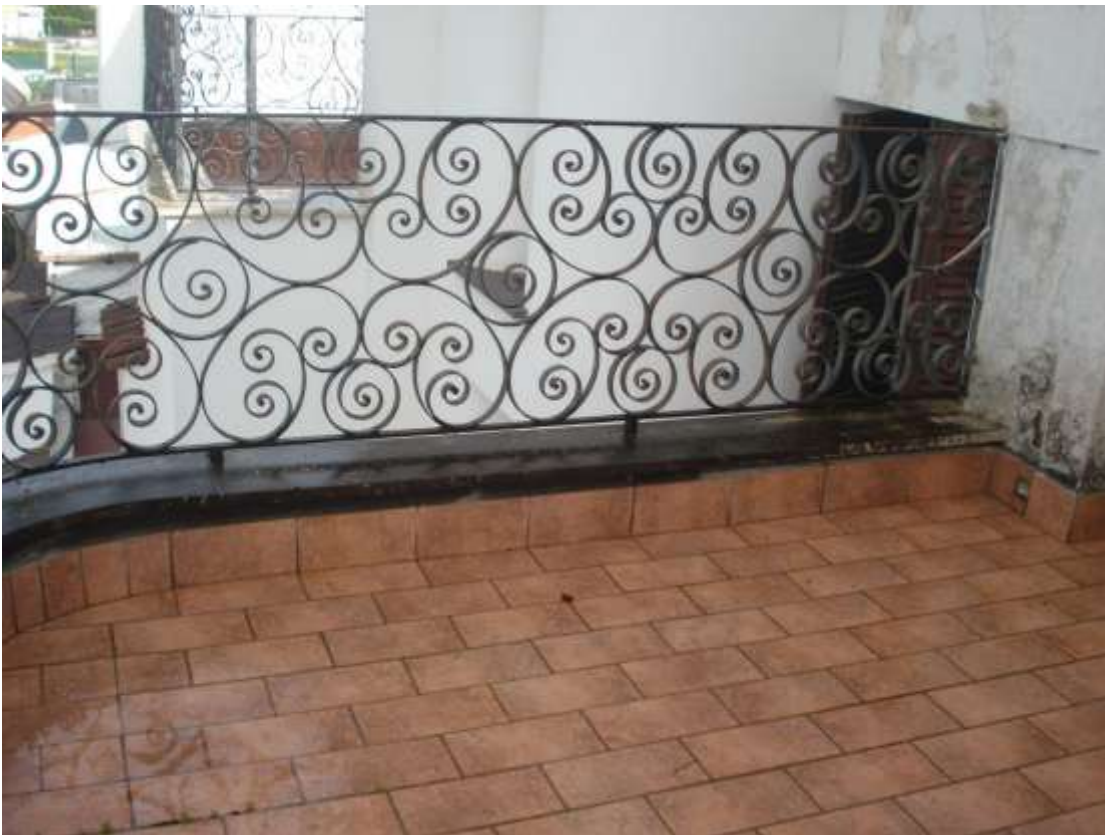
FOTO n° 46 : Altro particolare del terrazzo e della ringhiera di bordo in ferro.
