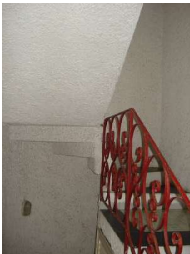
FOTO n° 34 : La ripartenza della scala, superato altri 7/8 gradini, per l'arrivo al piano 2°.
